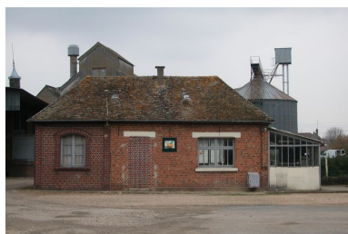
Le bureau, façade sur cour.
