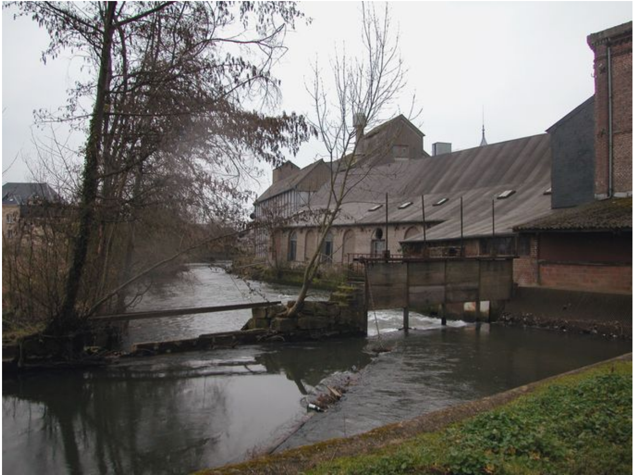
Le vannage de décharge et le déversoir.
