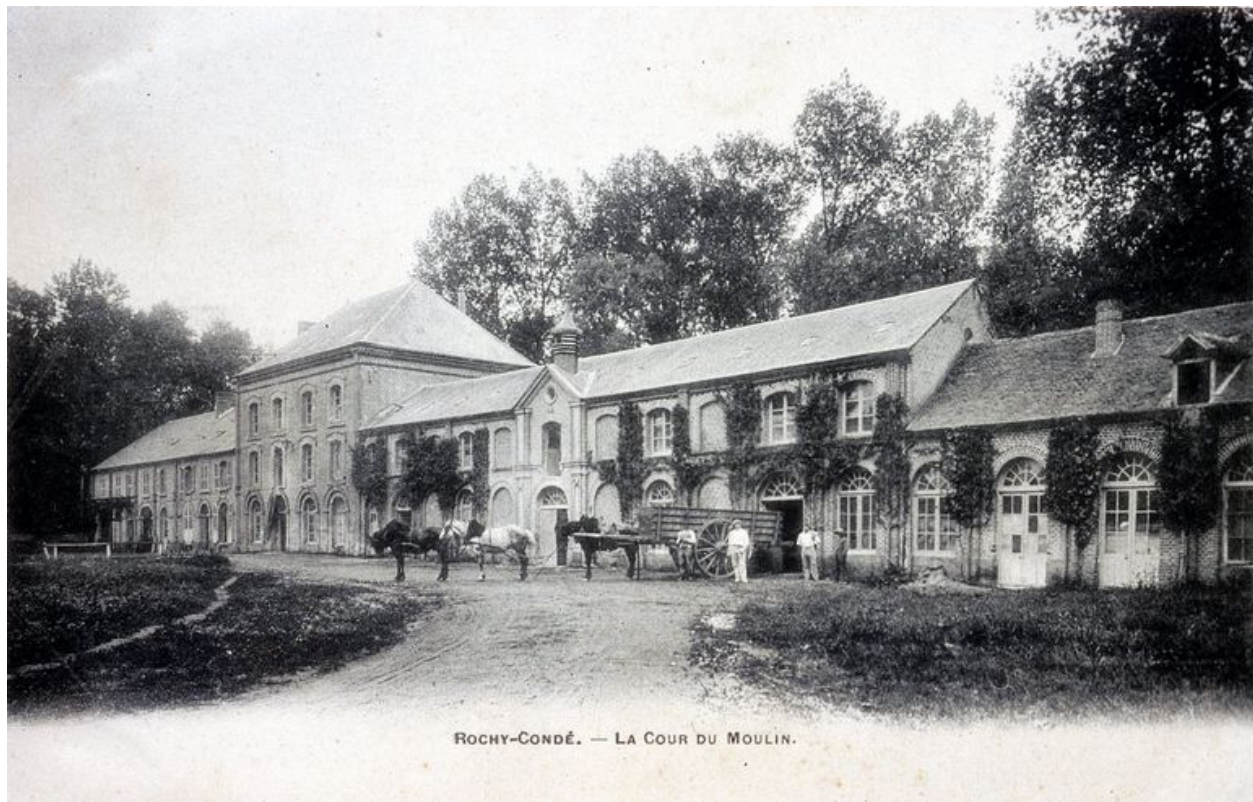
Vue d'ensemble, façade sur cour vers 1906 (Carte postale, coll. part.).
