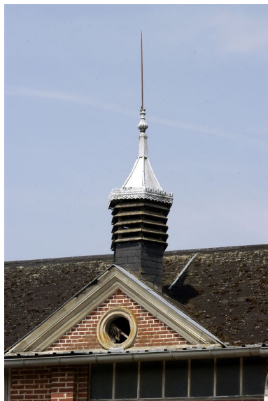
Détail du lanternon. Phot. Thierry Lefébure IVR22_20046000165NUCA
