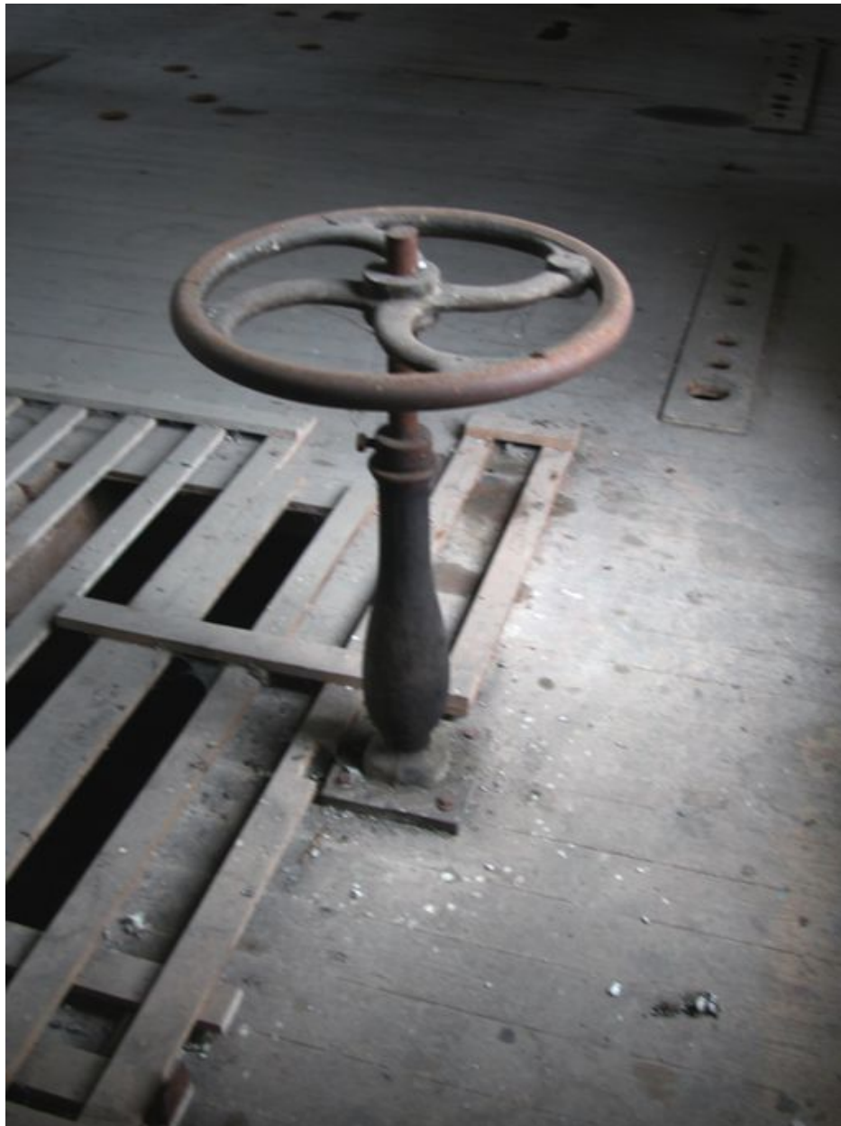
Intérieur du premier étage, détail du volant de commande d'ouverture de la vanne mouloire.
