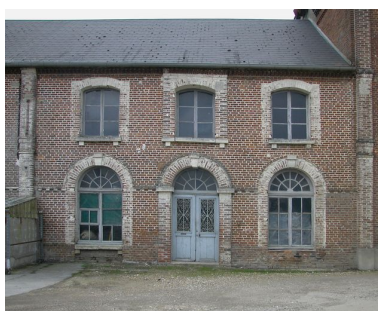
Façade sur cour, vue partielle. Phot. Bertrand Fournier IVR22_20046002783NUCA
