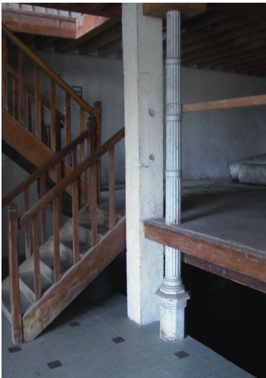
Détail d'une colonne cannelée en fonte, rez-de-chaussée.
