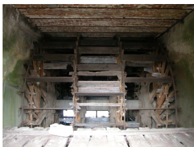
La roue hydraulique, vue de face. Phot. Bertrand Fournier IVR22_20046002787NUCA
