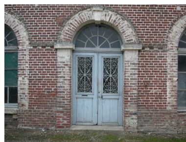
Détail de la porte d'entrée. Phot. Bertrand Fournier IVR22_20046002784NUCA
