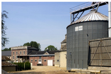
Vue d'ensemble depuis les silos modernes. Phot. Thierry Lefébure IVR22_20046000167NUCA
