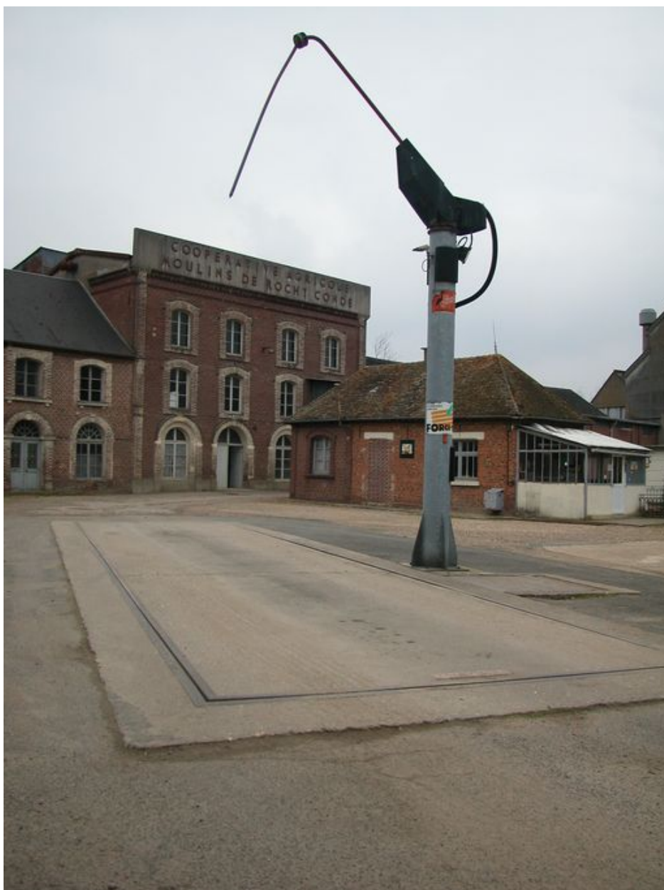
Vue d'ensemble de la minoterie sur cour.
