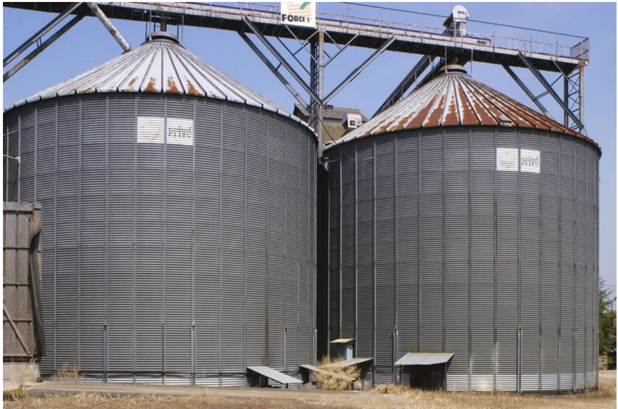
Les silos modernes, vue d'ensemble.
