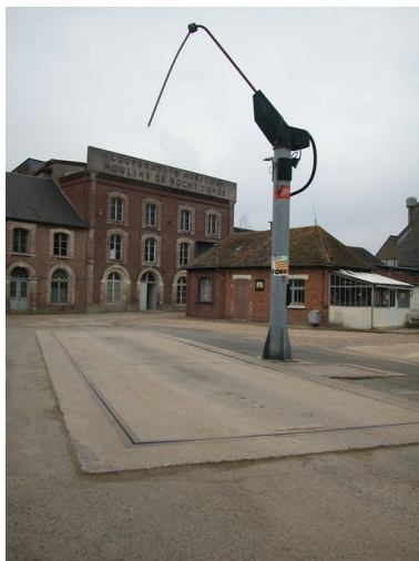
Vue d'ensemble de la minoterie sur cour. Phot. Bertrand Fournier IVR22_20046002785NUCA
