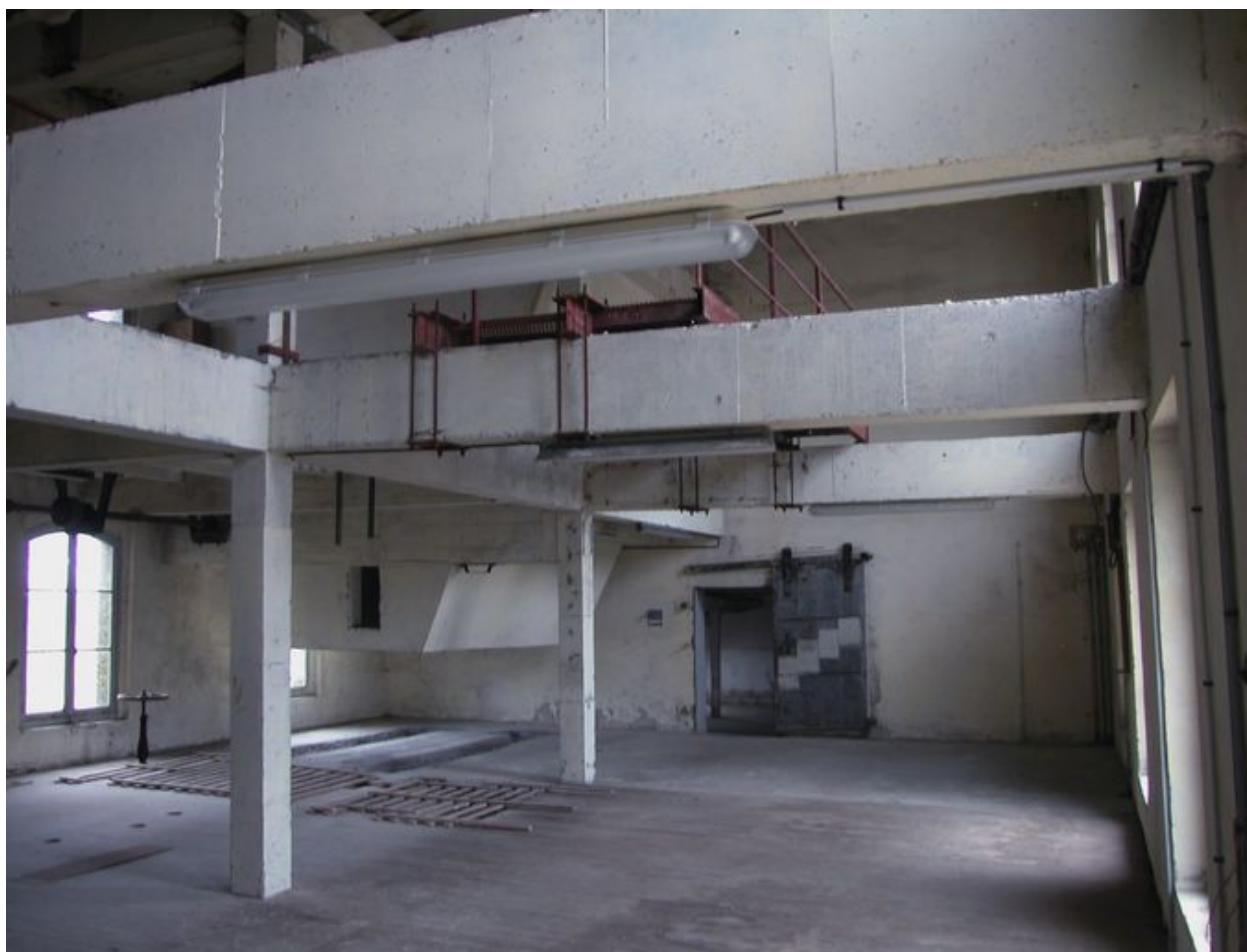
Intérieur du premier étage de la minoterie.
