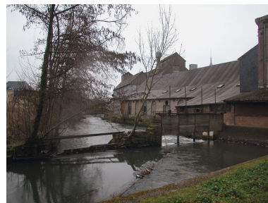
Le vannage de décharge et le déversoir. Phot. Bertrand Fournier IVR22_20046002789NUCA
