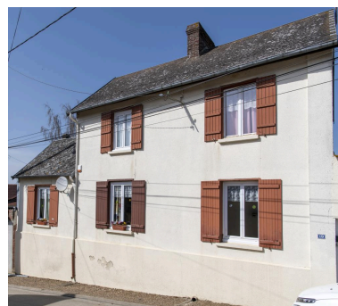
Ancien commerce (?) n°19 rue de Saint-Pierre, vue depuis le sud. Phot. Marc Kérignard IVR32_20216000132NUCA
