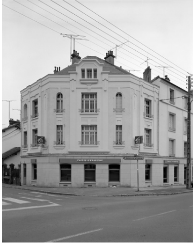
Vue d'ensemble du bâtiment, 1938, architecte G. Vaudescal. Phot. Thierry Lefébure IVR22_19950203238V
