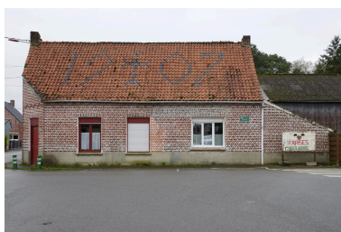
Façade nord. Date portée sur toiture : 1901. Phot. Delphine Volto Jourdan IVR32_20245903029NUCA
