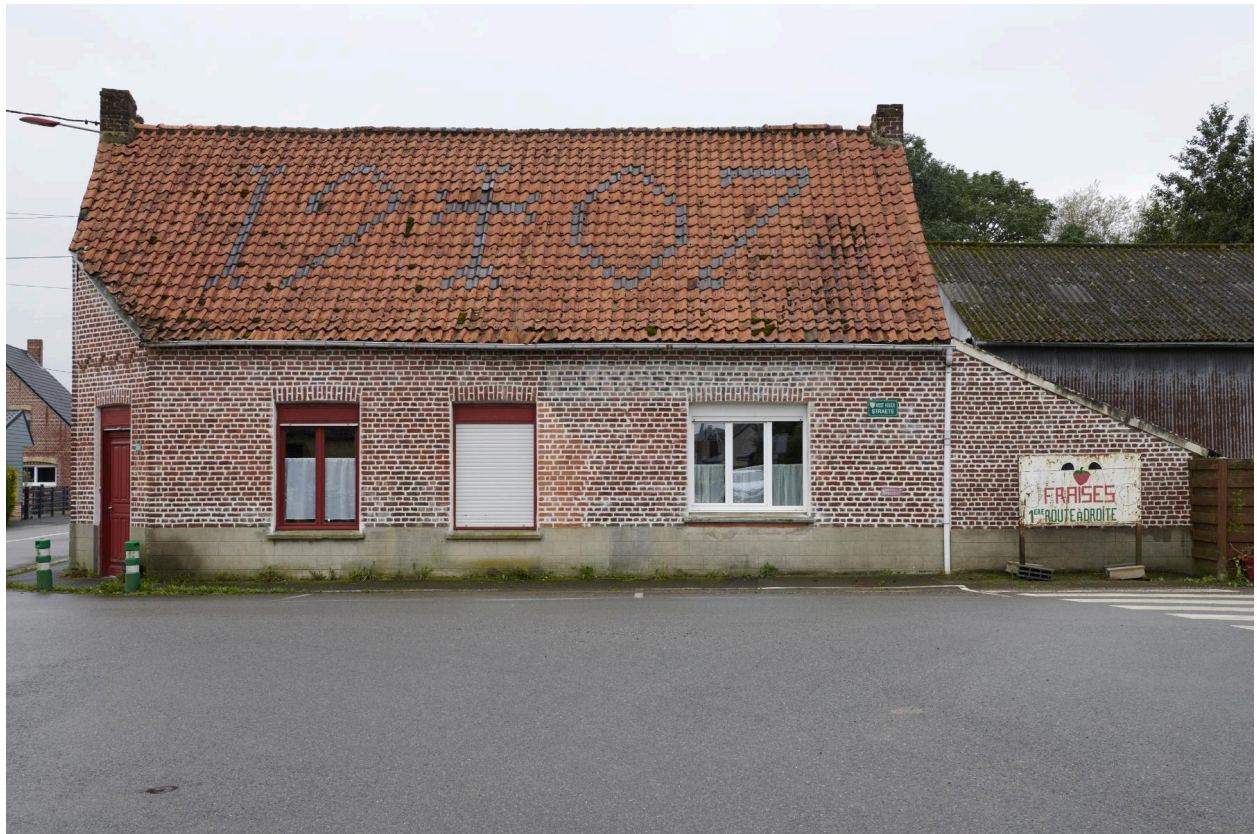
Façade nord. Date portée sur toiture : 1901.
