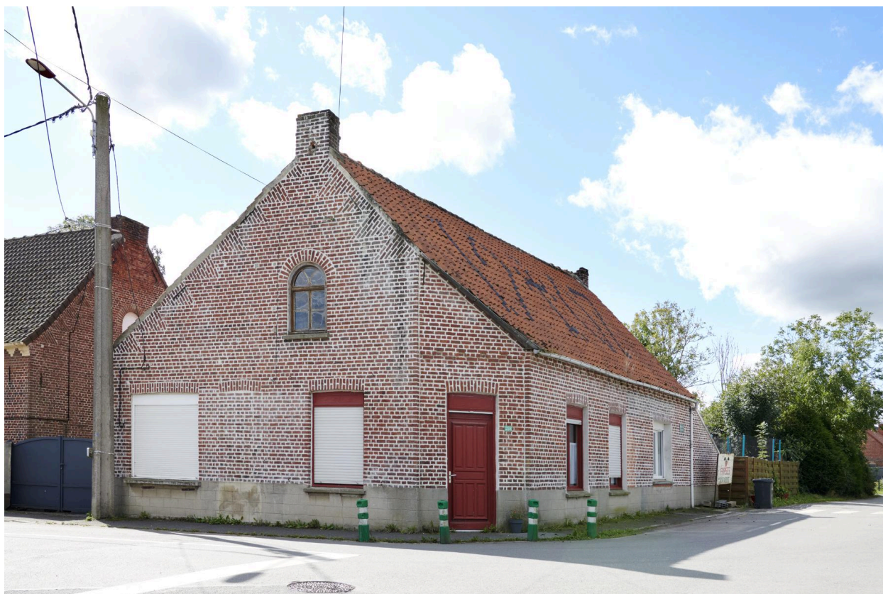
Façade nord et pignon est, entrée par l'angle.
