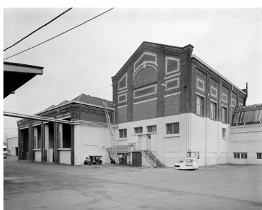
Ancienne salle des machines. Phot. Olivier Marlard IVR31_19905900368V
