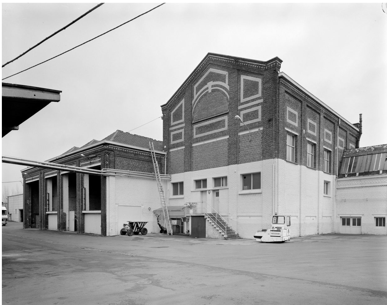
Ancienne salle des machines.
