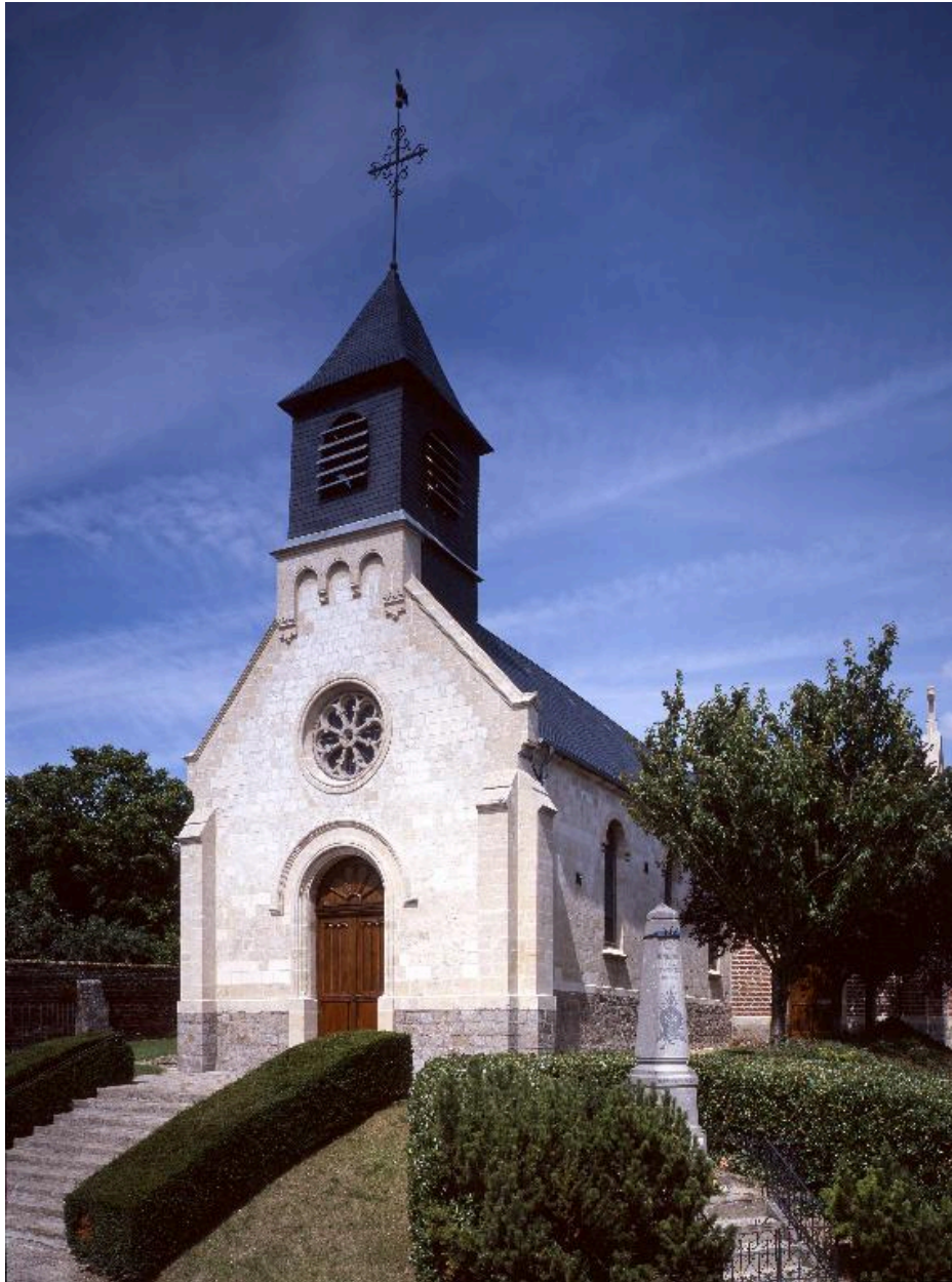
Vue générale, depuis le sud-ouest.
