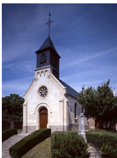
Vue générale, depuis le sud-ouest. Phot. Irwin Leullier IVR22_19988000730VA
