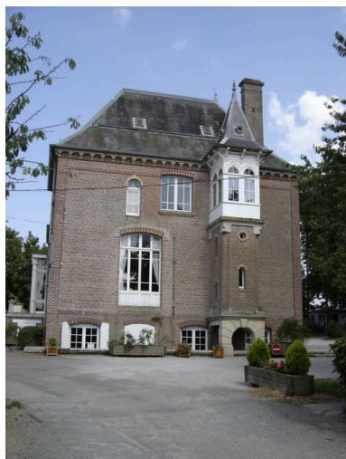
Vue latérale ouest.
