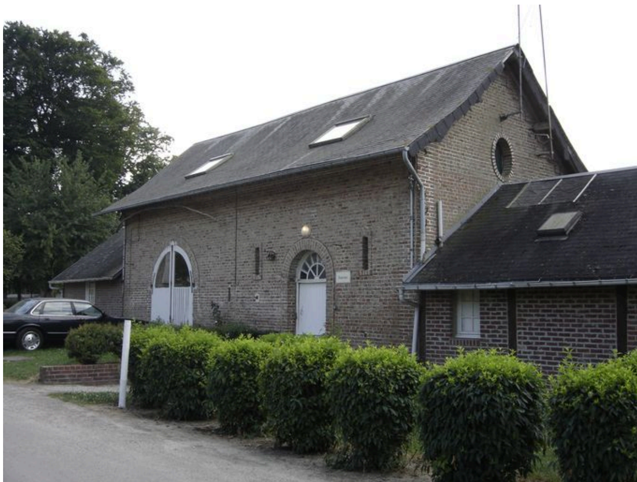
Vue de la grange.
