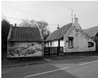
Vue générale. Phot. Philippe Dapvriil IVR31_20045900676X
