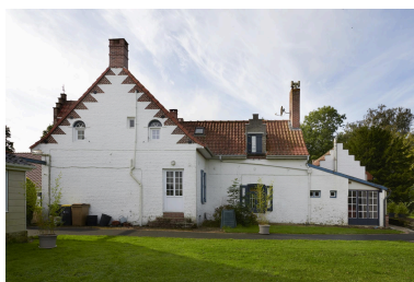
Pignon est du logis. Phot. Delphine Volto Jourdan IVR32_20255900809NUCA
