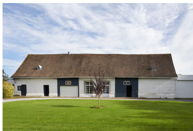
Dépendance est. Façade sur cour. Phot. Delphine Volto Jourdan IVR32_20255900806NUCA
