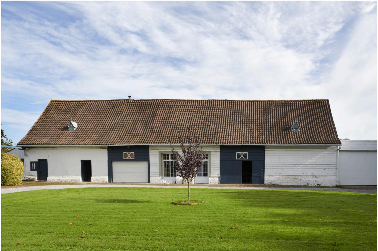
Dépendance est. Façade sur cour.
