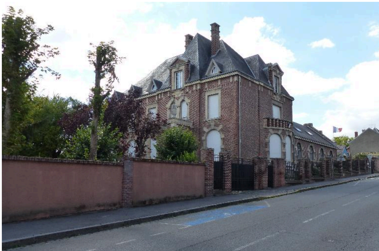
Sous-préfecture de Péronne.
