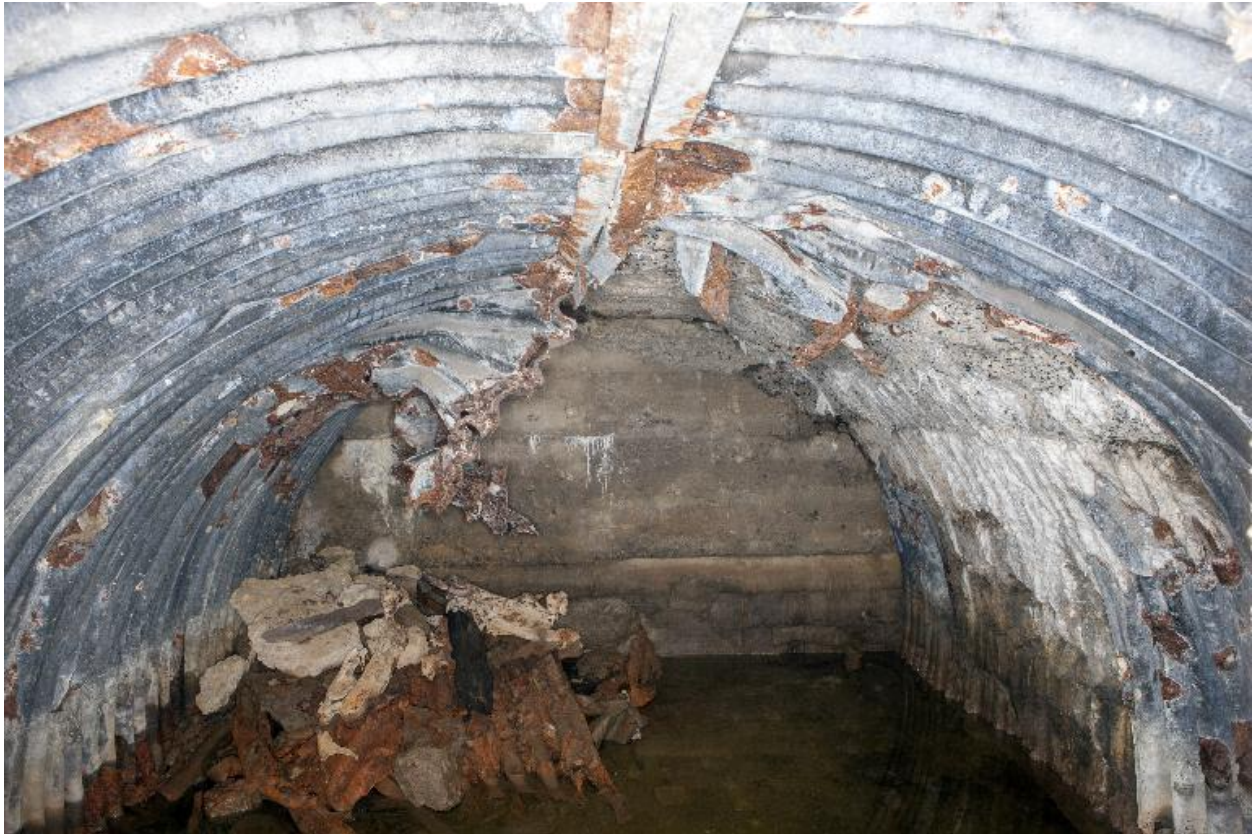
Casemate A. Salle perpendiculaire au couloir
