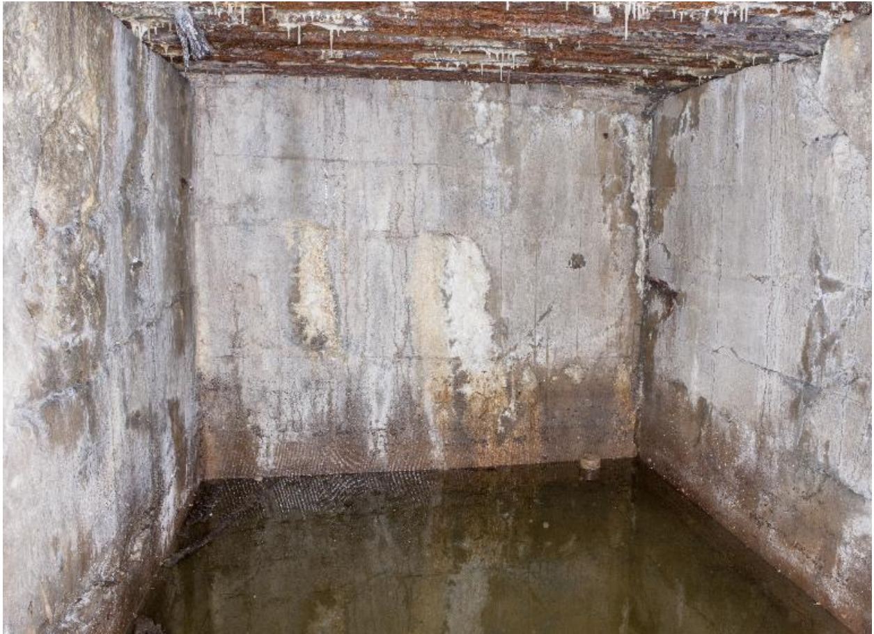
Casemate A. Arrière salle.
