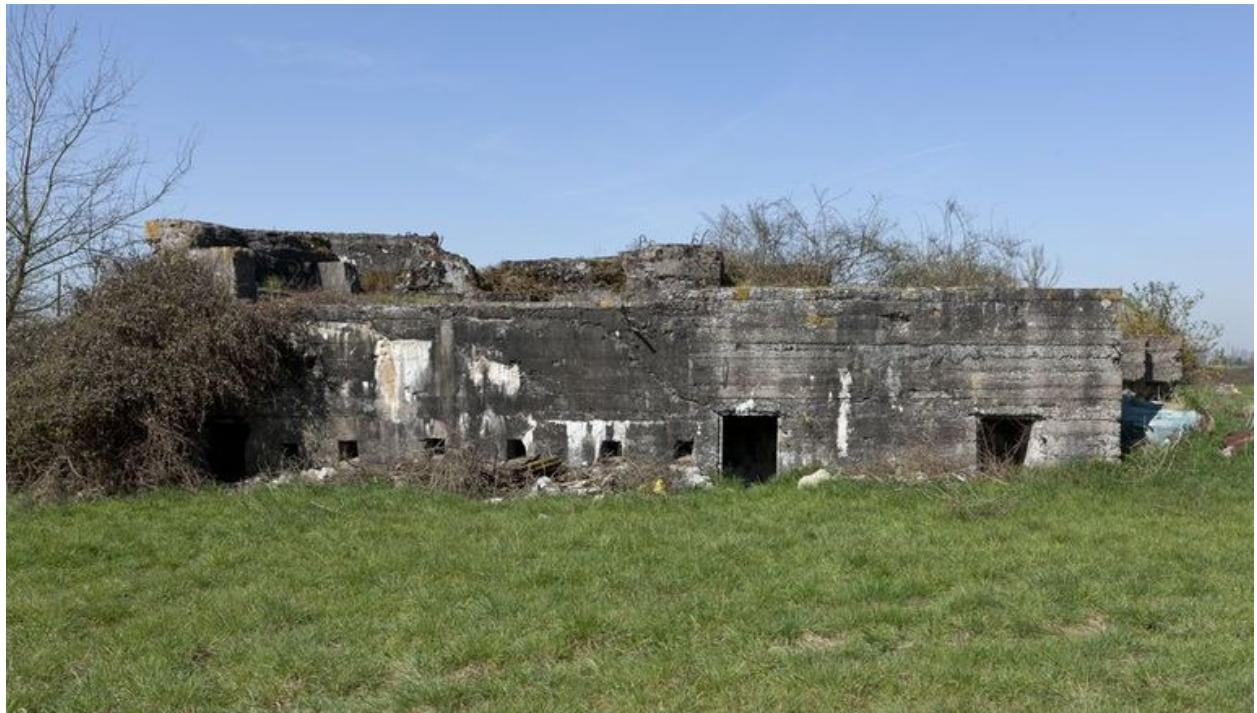
Casemate A : Vers le nord ouest
