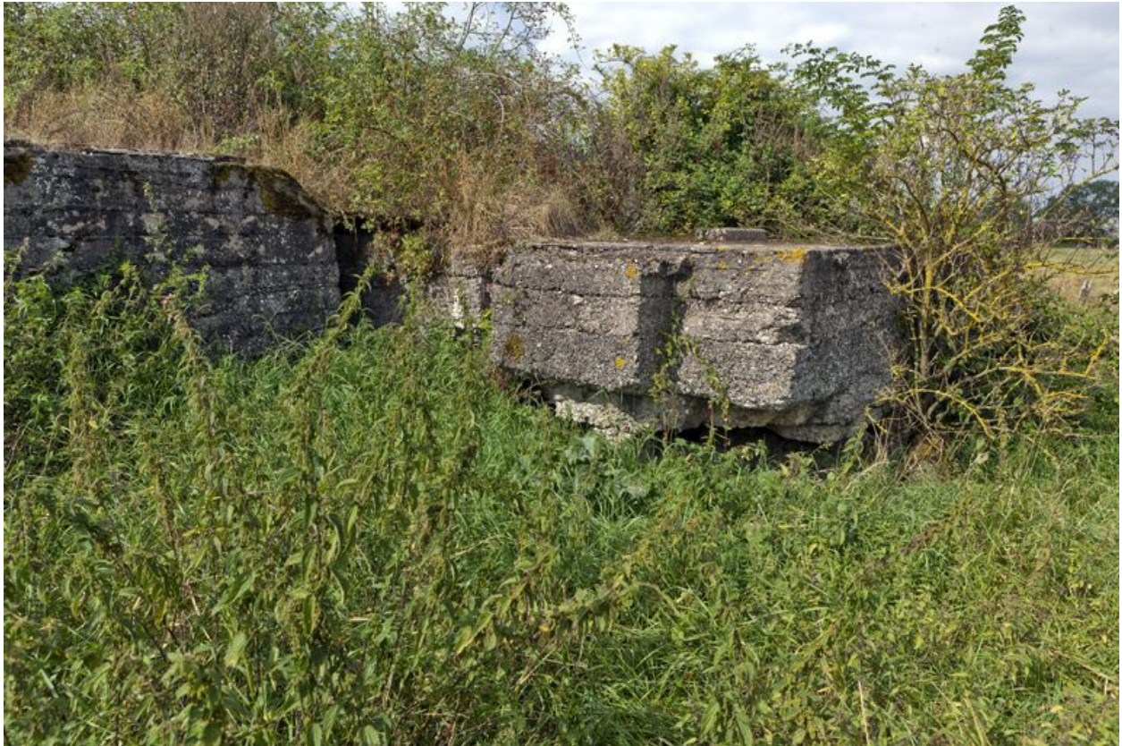
Casemate A : Extrémité nord-est
