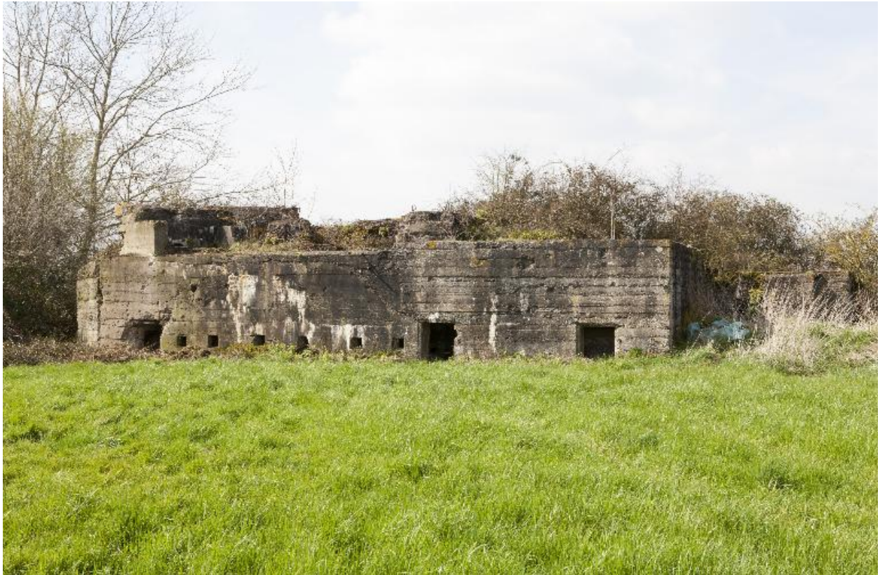
Casemate A : Vers le nord ouest
