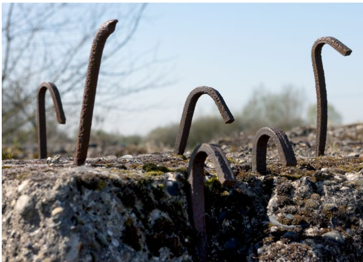
Bâtiment A : Partie explosée du toit, détail du ferrailage
