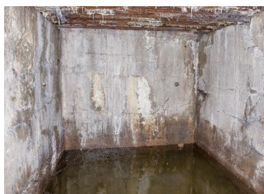
Casemate A. Arrière salle. Phot. Pierre Thibaut
