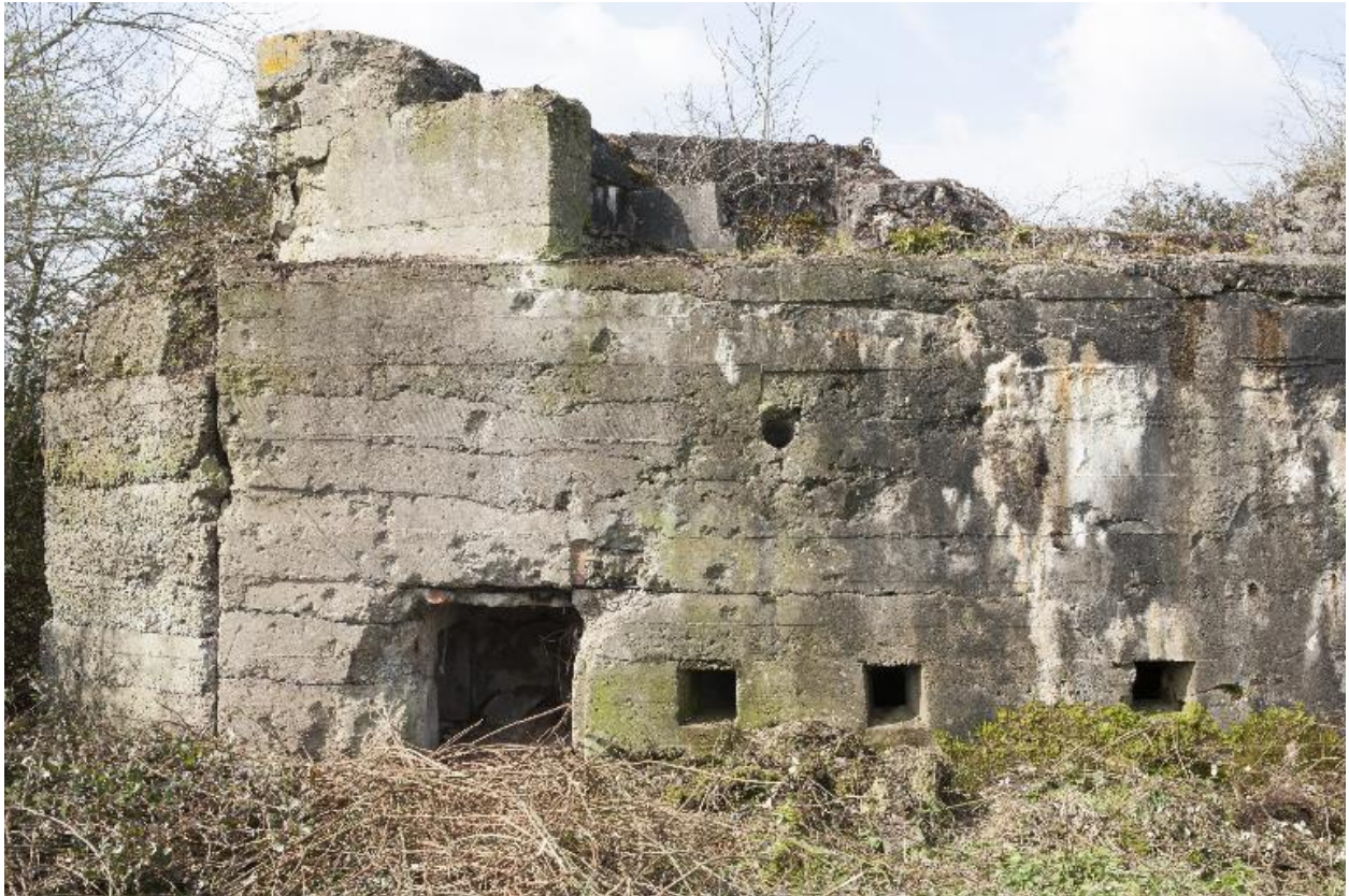
Casemate A : Entrée sud-ouest
