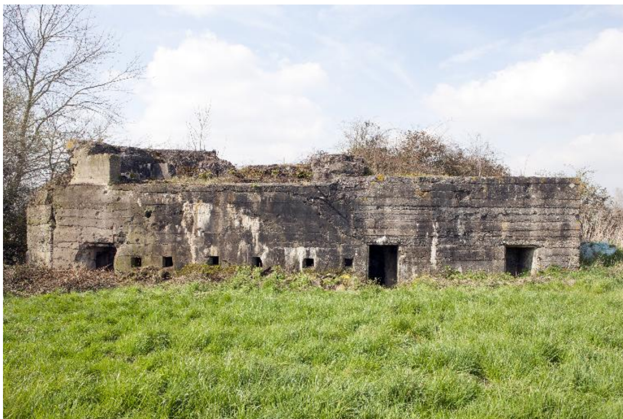
Casemate A : Vers le nord ouest
