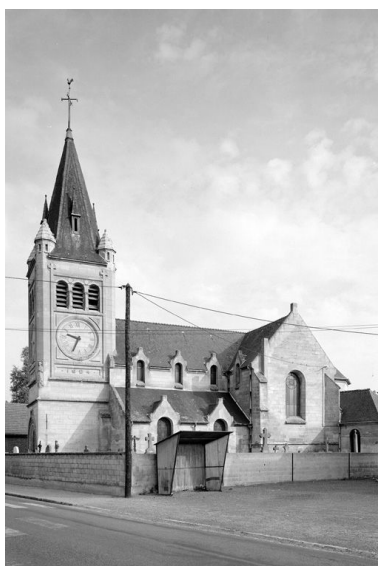
Élévation sud. Phot. Jean-Michel Périn IVR22_19846001146X
