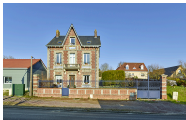
Vue de la maison depuis le sud-ouest. Phot. Thierry Lefébure IVR32_20258000234NUCA
