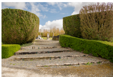
Accès au cimetière : escalier à pas d'âne. Phot. Marc Kérignard IVR32_20266000015NUCA
