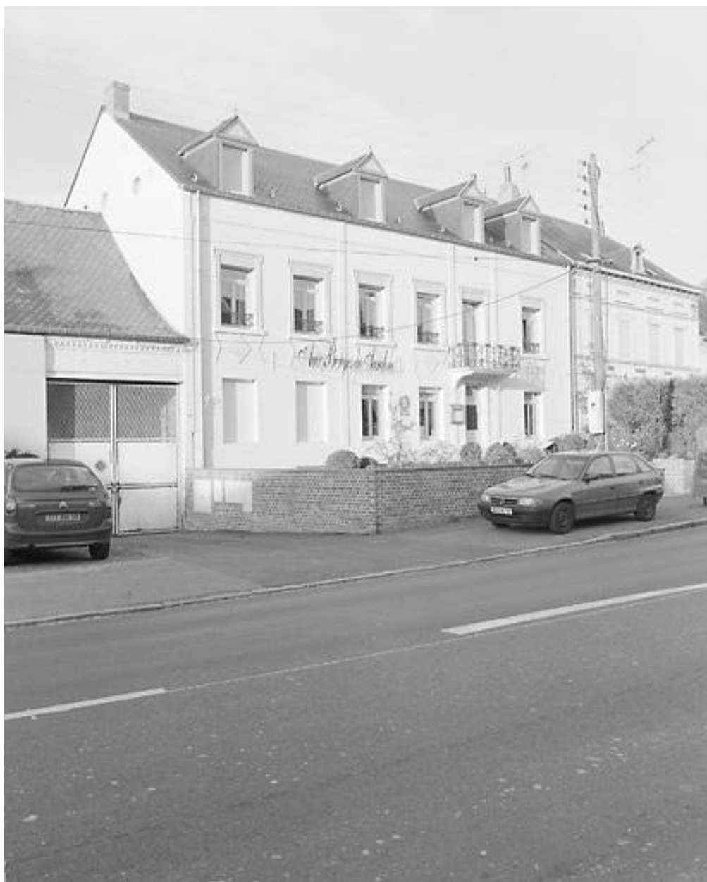
Élévation antérieure de la maison.
