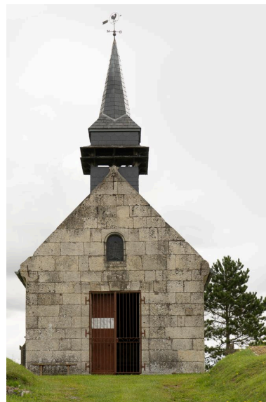
Vue de la façade occidentale de la chapelle Saint-Martin. Phot. Marc Kérignard IVR32_20216000912NUCA
