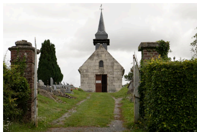
Entrée du cimetière. Phot. Marc Kérignard IVR32_20216000915NUCA
