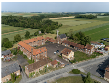
Vue aérienne de la cour nord depuis l'est. Phot. Marc Kérignard IVR32_20256000334NUCA
