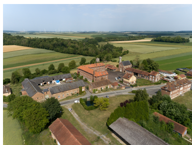
Vue aérienne du site depuis l'est. Phot. Marc Kérignard IVR32_20256000332NUCA
