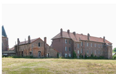
Vue générale de la cour des dortoirs depuis le nord-ouest. Phot. Marc Kérignard IVR32_20256000341NUCA
