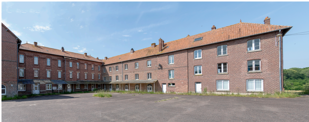
Vue générale des dortoirs depuis l'est.
