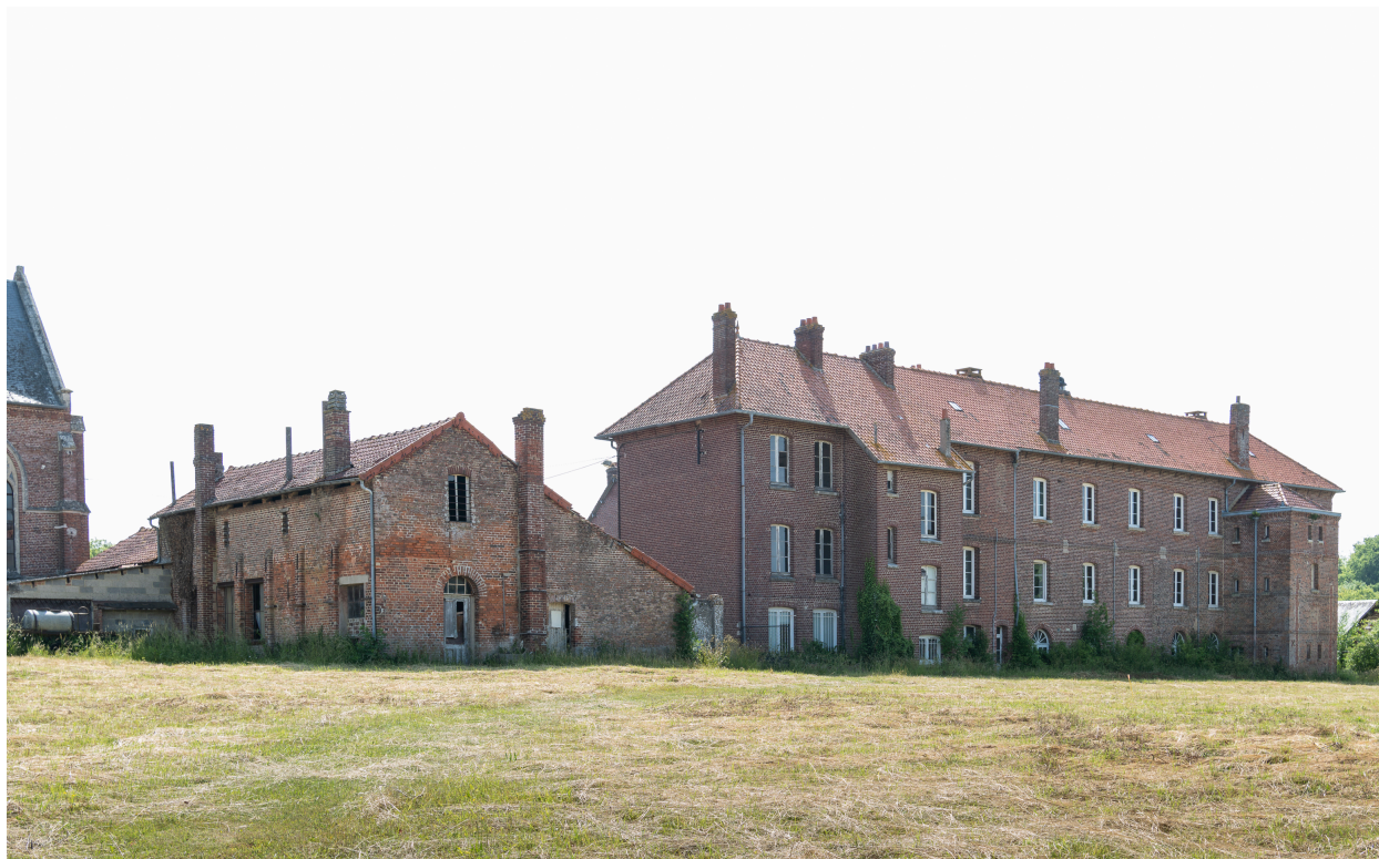
Vue générale de la cour des dortoirs depuis le nord-ouest.
