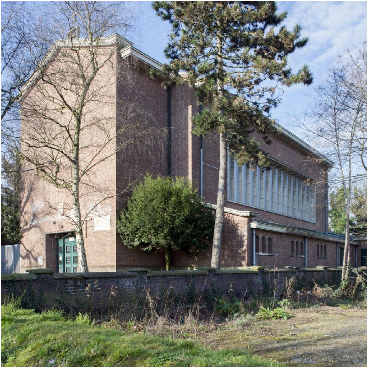
Élévation antérieure et flanc droit.
