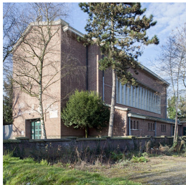
Élévation antérieure et flanc droit.
