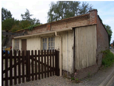
Vue de l'atelier. Phot. Inès Guérin IVR22_20078005131NUCA
