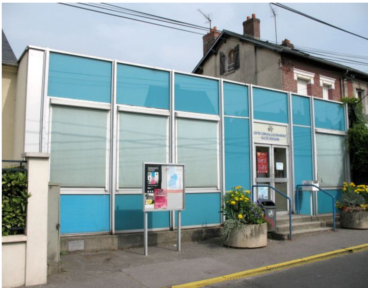
Façade de l'ancien atelier de mécanographie.
