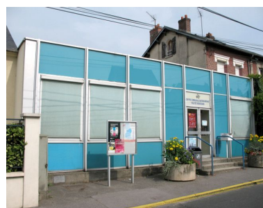
Façade de l'ancien atelier de mécanographie.
