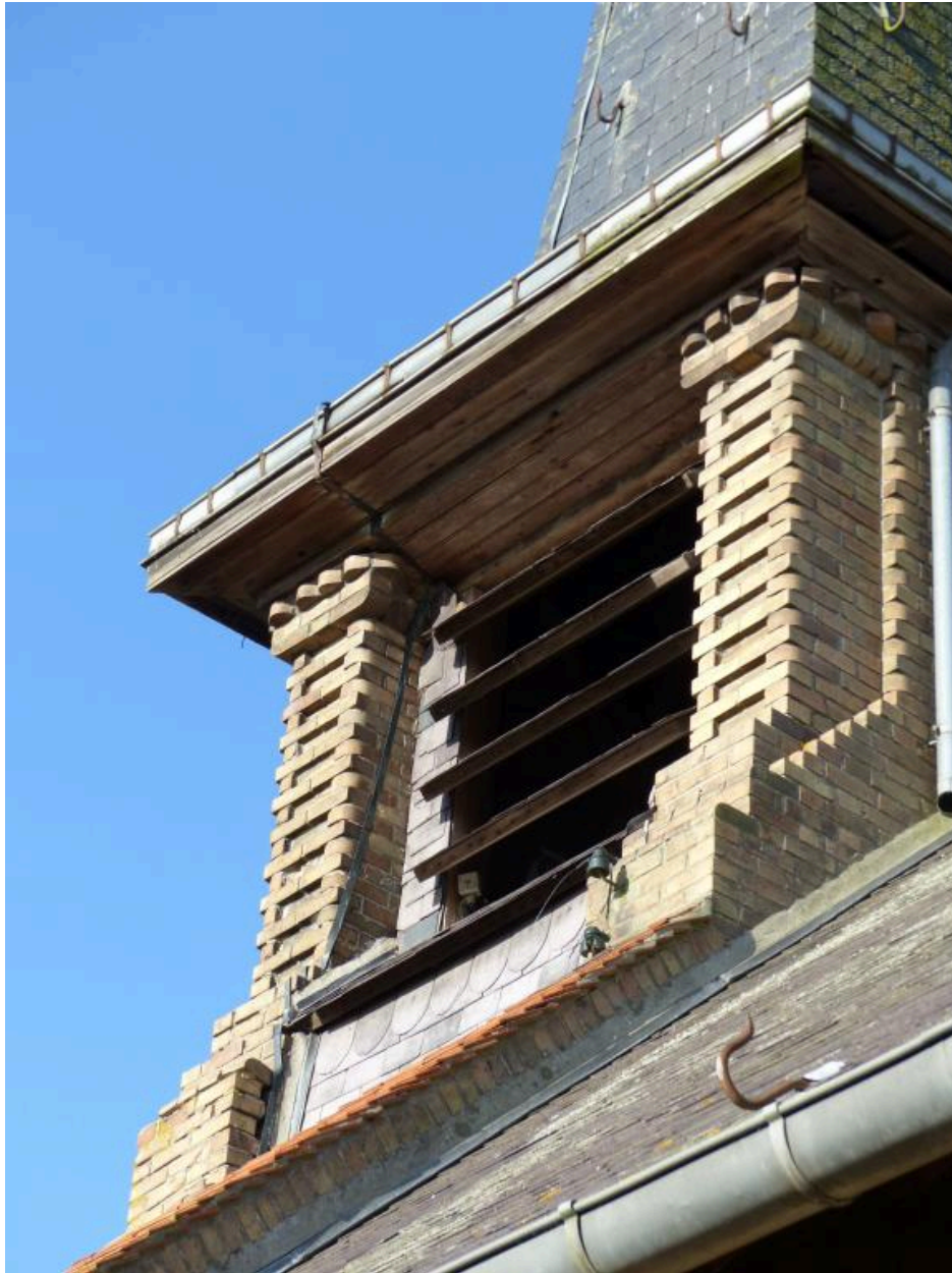
Vue de détail sur l'abat-son du clocher.
