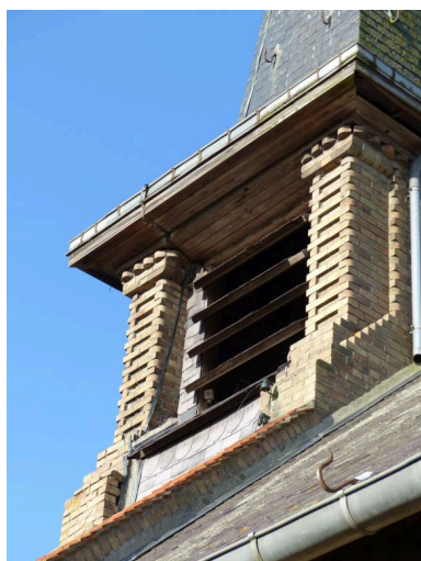
Vue de détail sur l'abat-son du clocher. Phot. Isabelle Barbedor IVR32_20168006544NUCA
