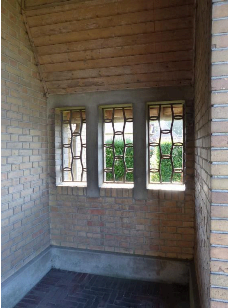
Vue de détail de l'intérieur du porche.
