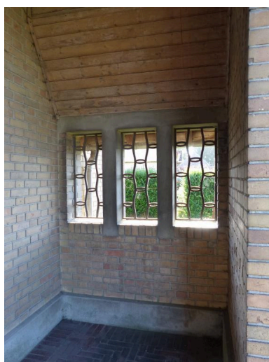
Vue de détail de l'intérieur du porche. Phot. Isabelle Barbedor IVR32_20168006545NUCA
