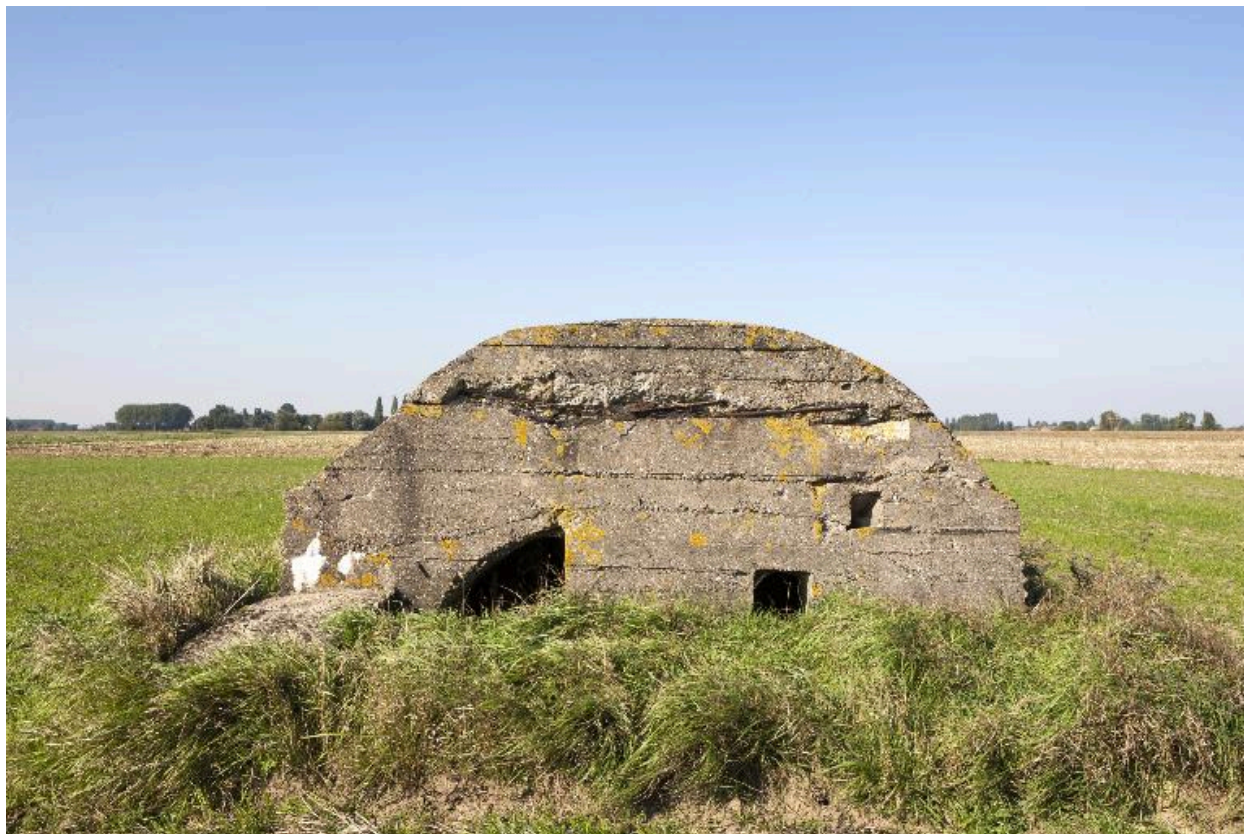
Entrée sur l'élévation sud
