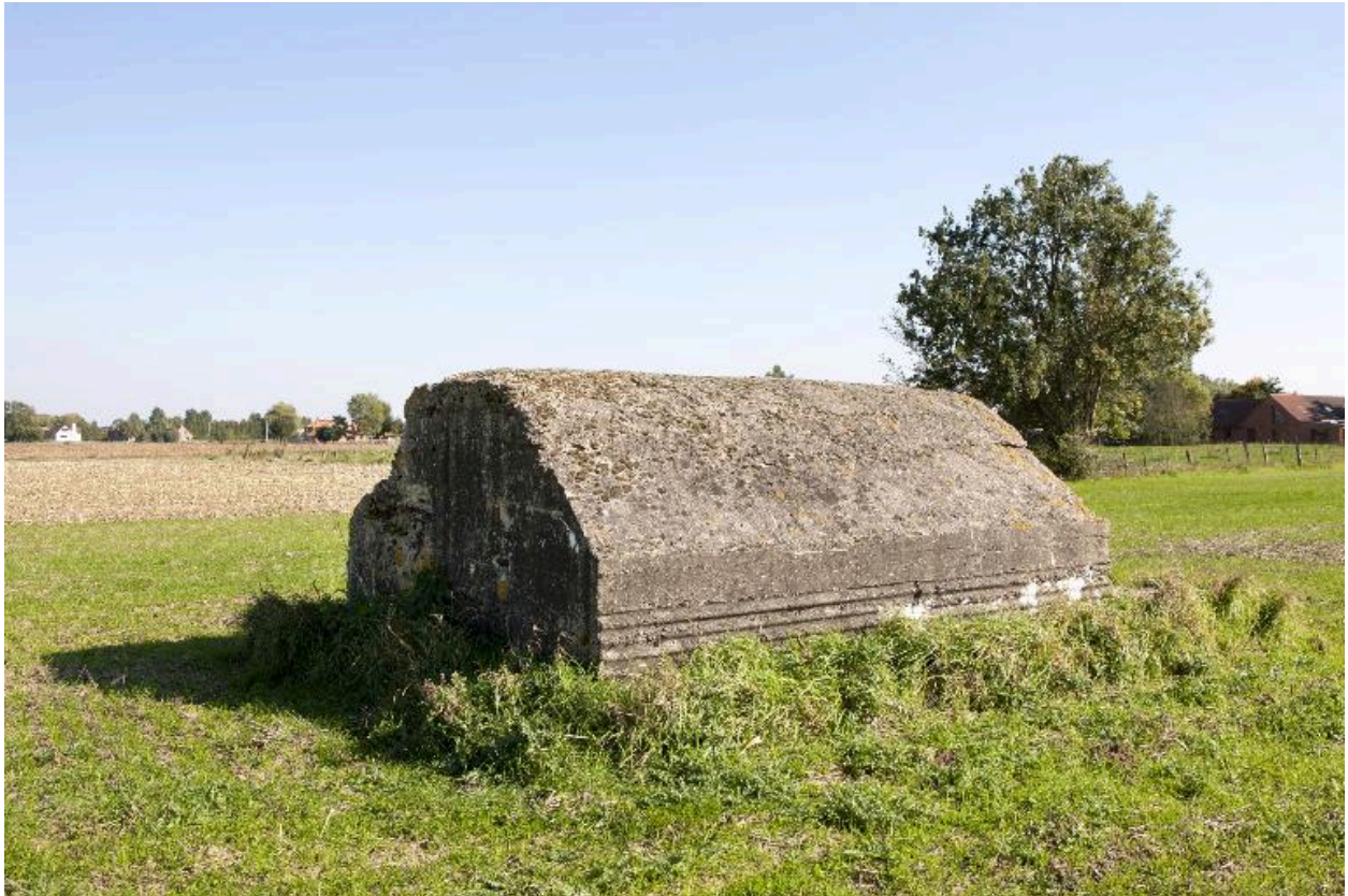
Vue de trois-quarts vers le sud-est
