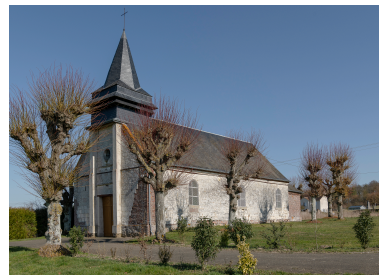
Vue générale de l'église depuis le sud-ouest. Phot. Marc Kérignard IVR32_20256000071NUCA
