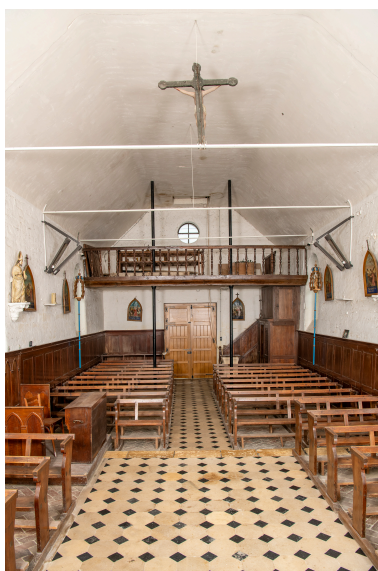
Vue intérieure vers la nef. Phot. Marc Kérignard IVR32_20256000047NUCA
