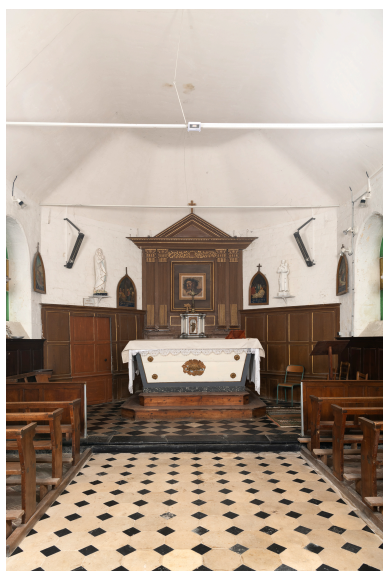
Vue intérieure du chœur. Phot. Marc Kérignard IVR32_20256000034NUCA
