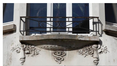
Détail de l'encorbellement de la baie du premier étage orné de rubans, d'un motif zigzagant et de fleurs. Phot. Pierre Thibaut IVR31_20096200181NUCA
