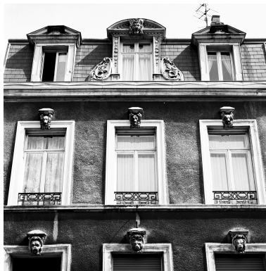
Façade sur voie, vue d'ensemble des clefs. Phot. Philippe Dapvril IVR31_19946200477X
