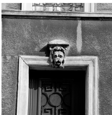
Clef 6, chien n° 6, rez-de-chaussée, travée nord, linteau porte d'entrée. Phot. Philippe Dapvril, Phot. Philippe Caudroit IVR31_19946200588X
