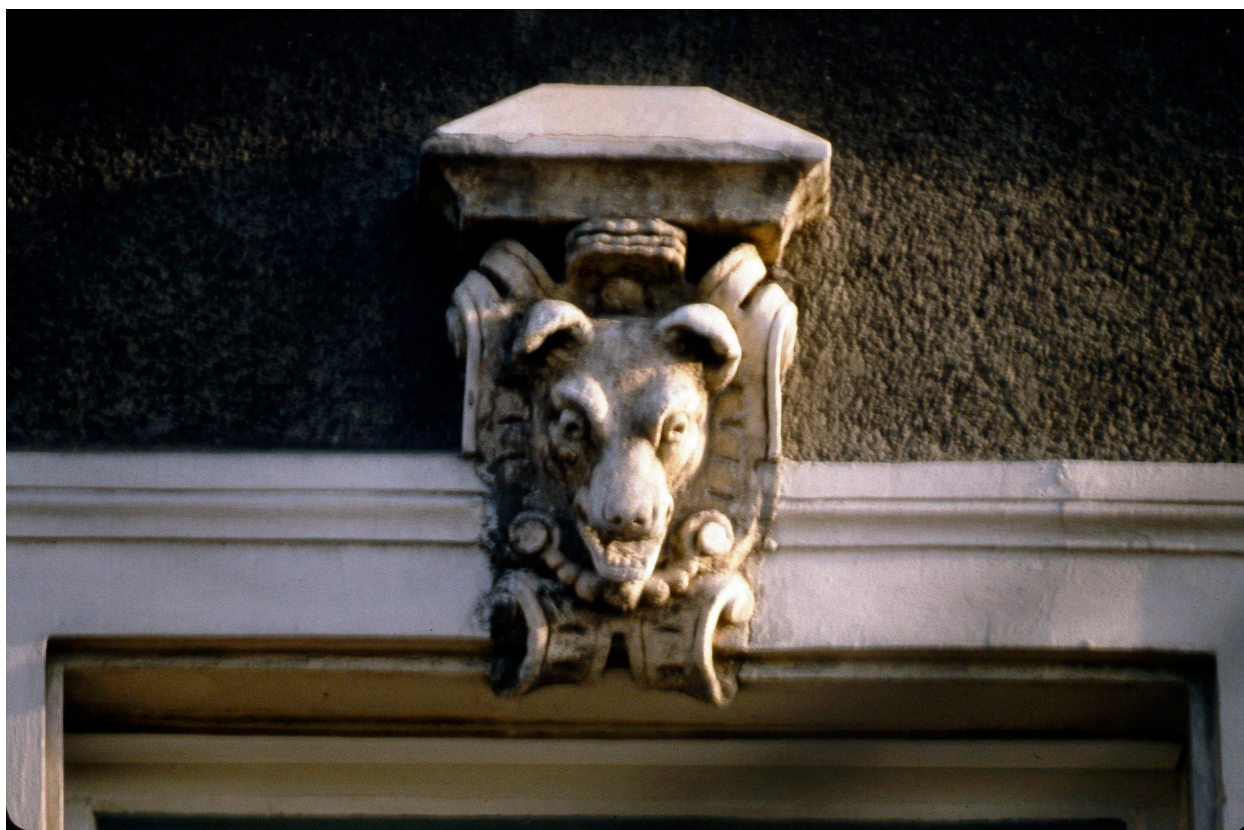
Clef 1, chien n° 1, étage, travée centrale.
