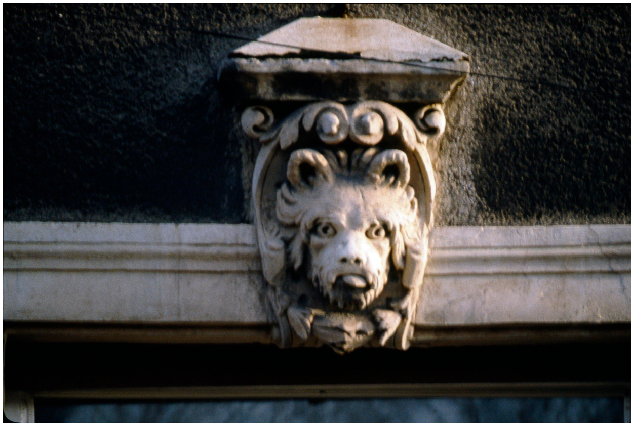
Clef 4, chien n° 4, rez-de-chaussée, travée centrale.
