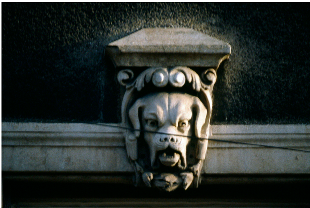
Clef 5, chien n° 5, rez-de-chaussée, travée sud.
