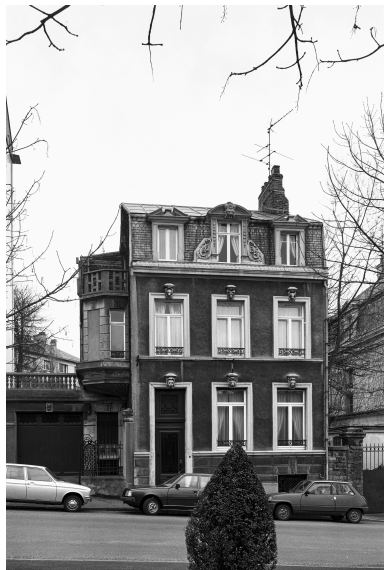
Façade sur voie. Phot. Philippe Caudroit IVR31_19816204544X
