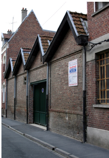
Façade antérieure des ateliers de 1922.
