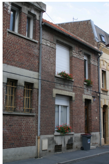
Logement accolé à l'usine.
