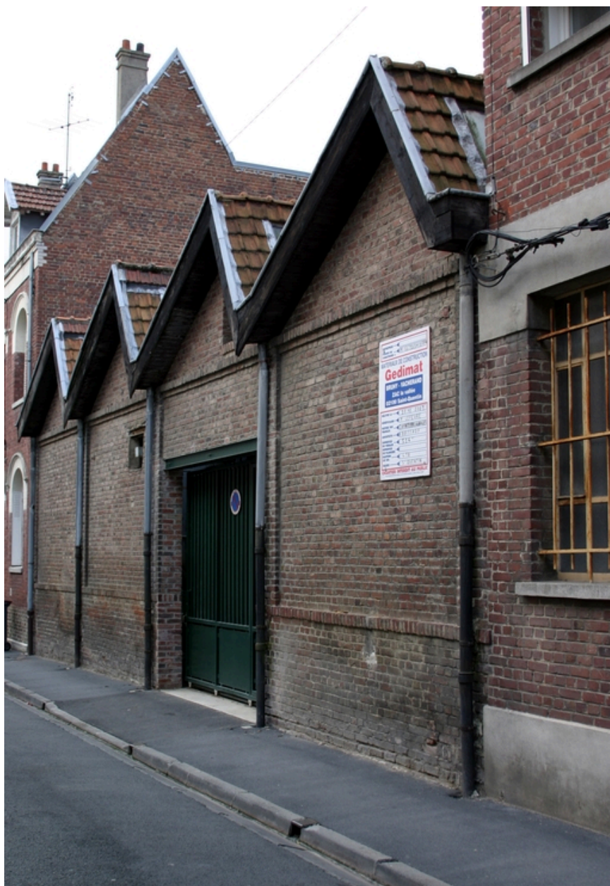
Façade antérieure des ateliers de 1922.
