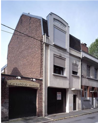
Vue générale. Phot. Pierre Thibaut IVR31_20086200186VA
