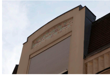
Vue sur le fronton droit à encorbellements, orné de décors floraux. Phot. Pierre Thibaut IVR31_20096200279NUCA
