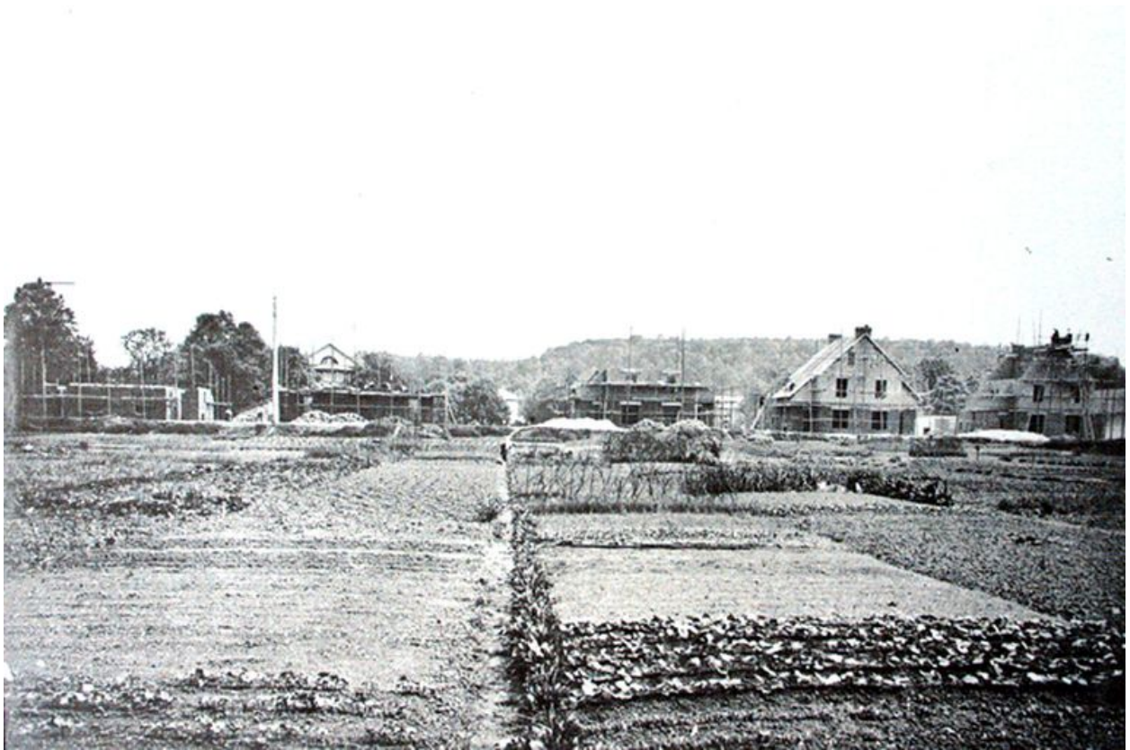
La cité du zinc en construction au milieu des années 1920 (AC Creil).
