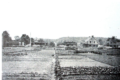
La cité du zinc en construction au milieu des années 1920 (AC Creil). Phot. Clarisse Lorieux IVR22_20076005236NUCAB
