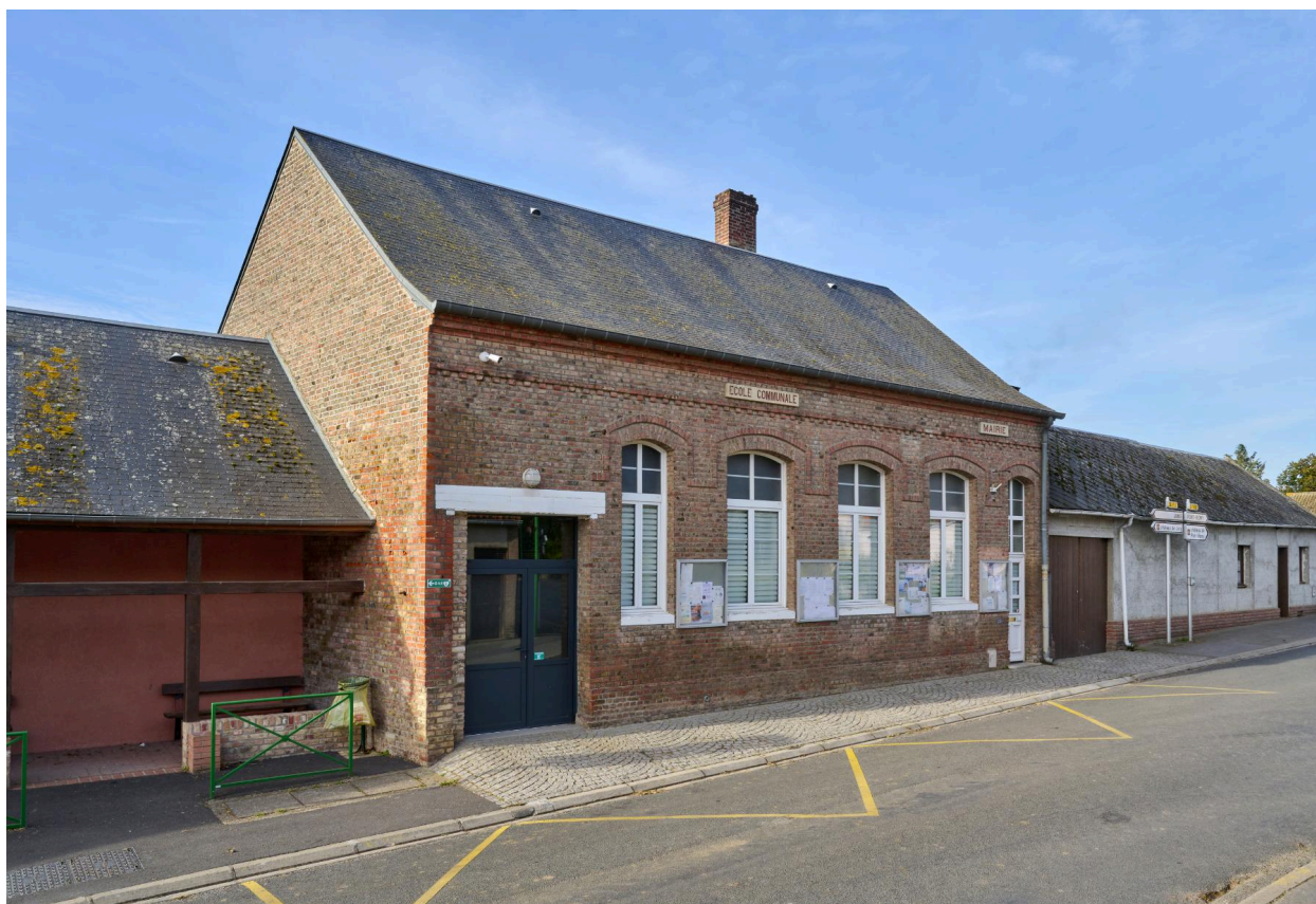
Mairie, vue prise depuis le nord-est.
