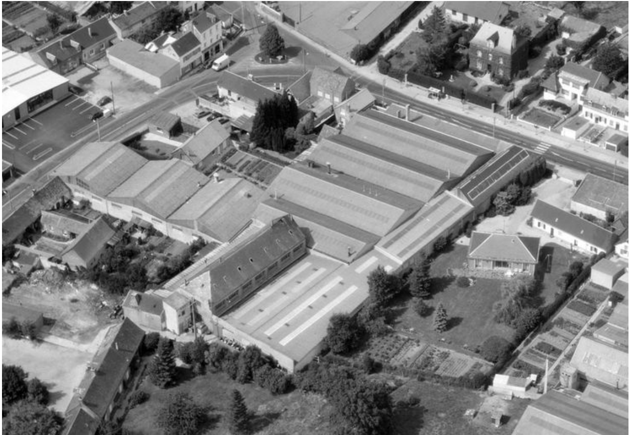
Vue aérienne en 1988, flanc sud-est.
