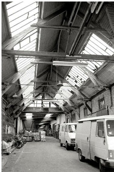
Vue intérieure de l'atelier antérieur à 1947, vue prise en 1990. La charpente et la verrière ont été supprimées.
