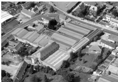
Vue aérienne en 1988, flanc sud-est.
