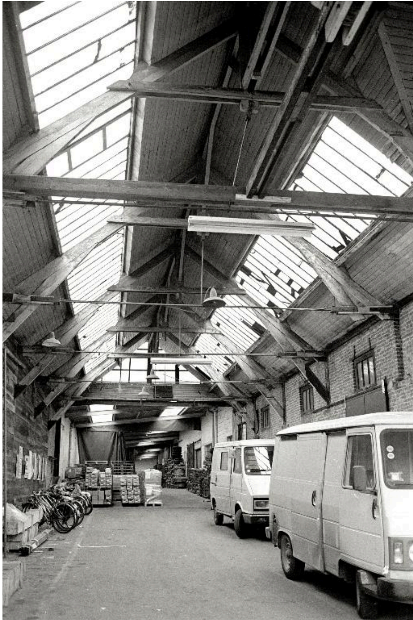
Vue intérieure de l'atelier antérieur à 1947, vue prise en 1990. La charpente et la verrière ont été supprimées.
