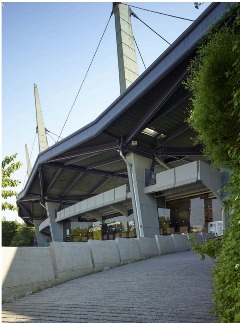
L'accès au stade métropolitain, depuis la rampe sud.
