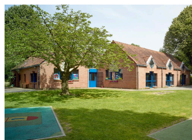
Le centre social Charlie-Chaplin, rue Champollion, vue depuis le sud. Phot. Pierre Thibaut IVR32_20185900641NUCA
