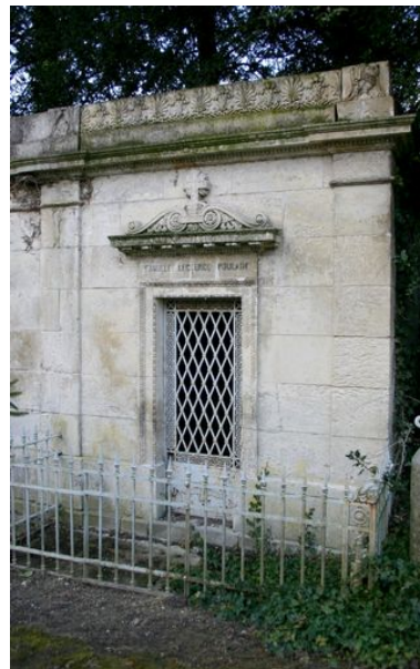
Vue du tombeau Leclercq-Poulain (N49). Phot. Caroline Vincent IVR22_20088000309NUCA
