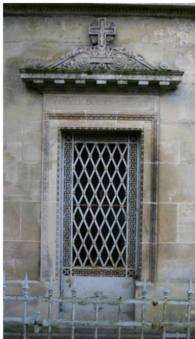
Détail du décor sculpté et de la porte en fonte ouvragée (N51).
