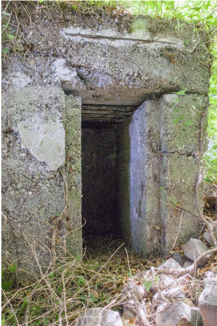
Entrée d'une casemate à personnel, probablement celle de la position I sur les document britanniques
