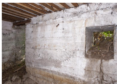
Vue intérieure de la casemate à personnel, probablement celle de la position I sur les document britanniques Phot. Pierre Thibaut IVR31_20155901332NUCA
