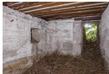
Vue intérieure de la casemate à personnel, probablement celle de la position I sur les document britanniques Phot. Pierre Thibaut IVR31_20155901331NUCA
