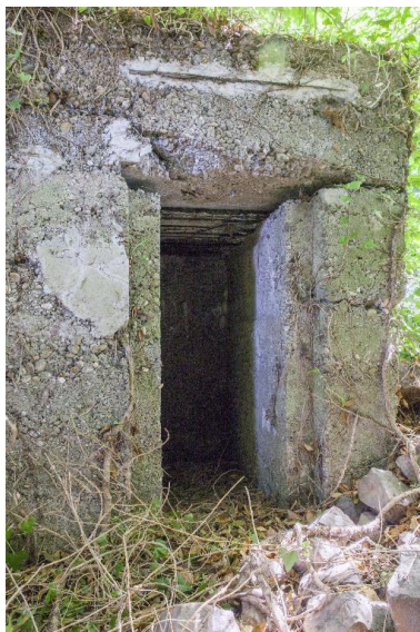
Entrée d'une casemate à personnel, probablement celle de la position I sur les document britanniques Phot. Pierre Thibaut IVR31_20155901333NUCA
