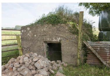
Casemate à munitions, probablement celle de la position II sur les document britanniques Phot. Pierre Thibaut IVR31_20155901327NUCA
