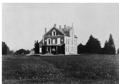
Vue du château détruit. Etat avant 1914 (AP). Phot. Jean-Michel Périn IVR22_19856000033XB
