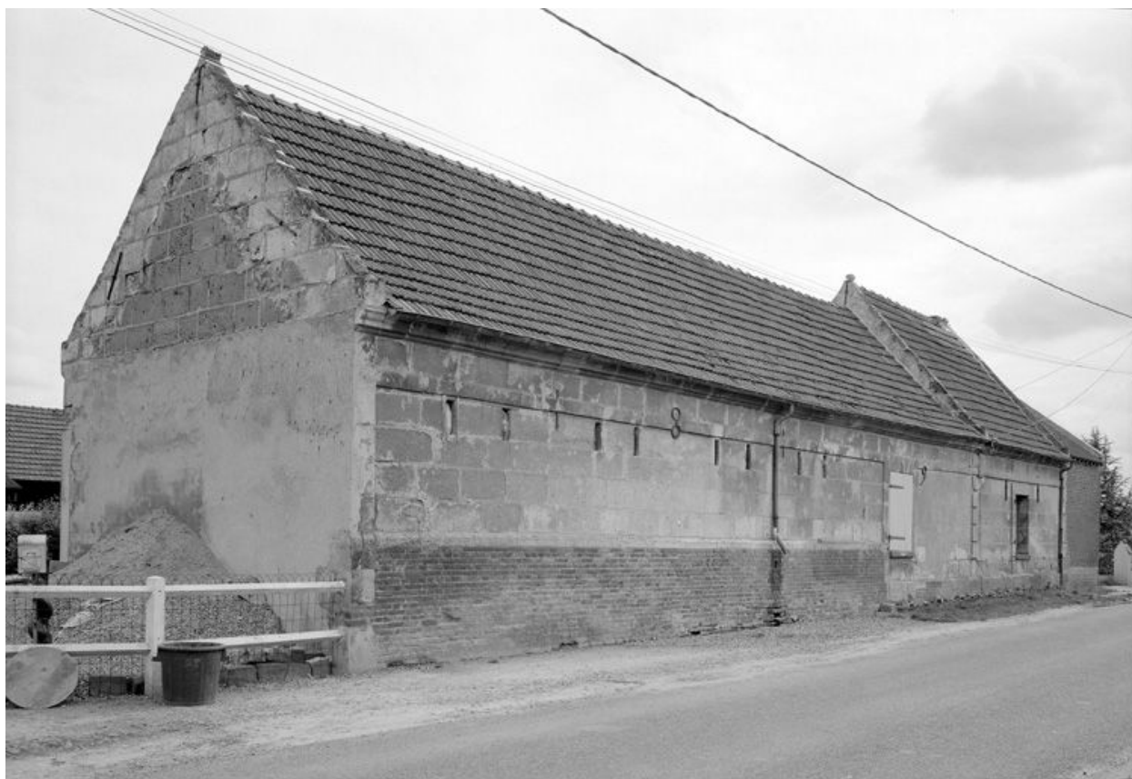
Élévation sur rue d'une ferme repérée portant la date de 1819.
