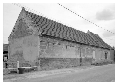
Élévation sur rue d'une ferme repérée portant la date de 1819. Phot. Jean-Michel Périn IVR22_19856000960X
