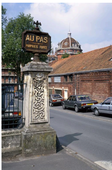
Vue d'un des montants de l'ancienne porte d'accès à l'enceinte du Familistère du côté de la rue Sadi-Carnot. Phot. Olivier Coquelle IVR22_19940200570XA
