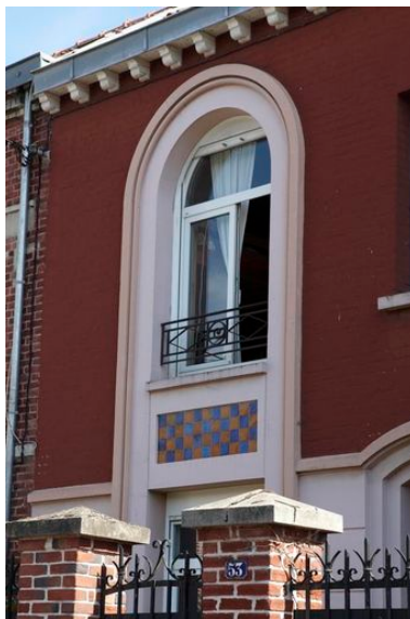
Vue sur une baie aux ornements Art déco. Phot. Pierre Thibaut IVR31_20096200289NUCA
