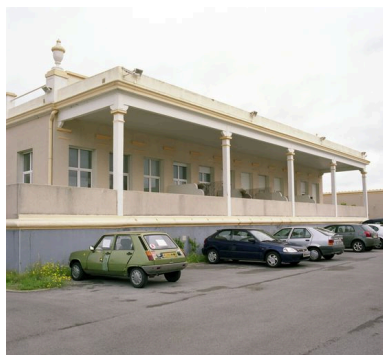
Elévation antérieure qui est dotée d'un solarium, vue générale prise de trois-quarts gauche. Phot. Pierre Thibaut IVR31_20096200028XE
