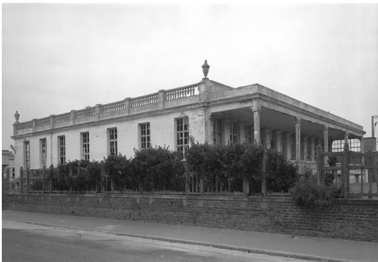
Élévation antérieure précédée de son solarium et élévation latérale gauche, vue d'ensemble.
