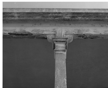
Elévation antérieure, détail du chapiteau d'un des piliers du solarium. Phot. Eric Dessert IVR31_19816203806X
