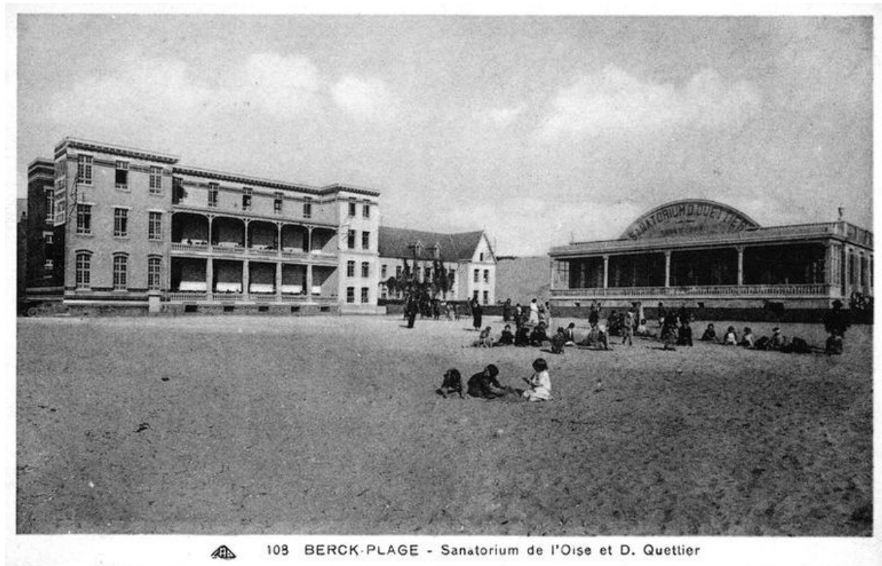
Vue montrant, sur la gauche, la façade donnant sur la rue du sanatorium de l'Oise et, sur la droite, l'élévation latérale sud du sanatorium Quettier. Carte postale, années 1920-1930 (coll. part.).
