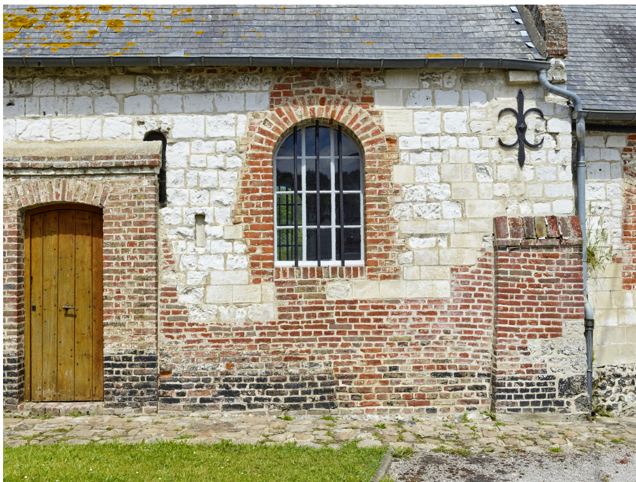
Détail de la maçonnerie de la façade sud.
