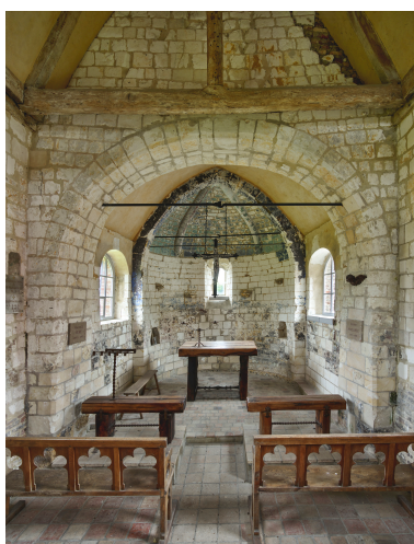
Intérieur, vue du chœur. Phot. Thierry Lefébure IVR32_20248000970NUCA
