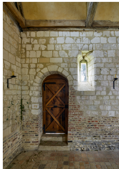
Intérieur, porte et baie sur l'élévation nord de la chapelle. Phot. Thierry Lefébure IVR32_20248000975NUCA
