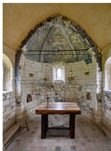
Intérieur, détail de l'abside. Phot. Thierry Lefébure IVR32_20248000971NUCA
