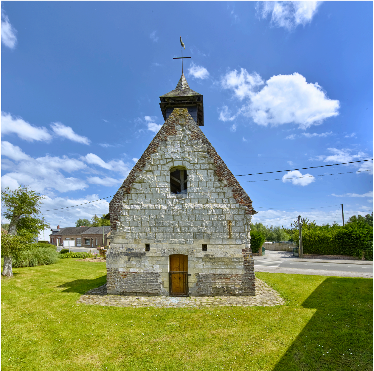
Façade ouest de la chapelle.
