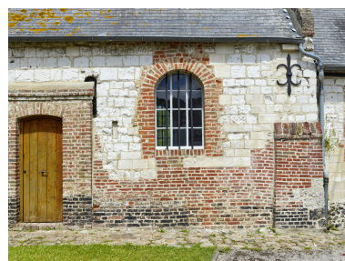
Détail de la maçonnerie de la façade sud. Phot. Thierry Lefébure IVR32_20248000965NUCA
