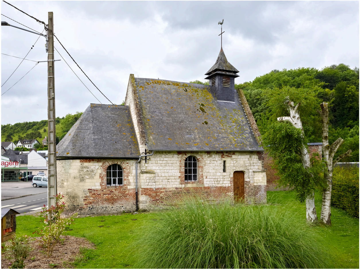
Vue d'ensemble de la chapelle, depuis le nord.
