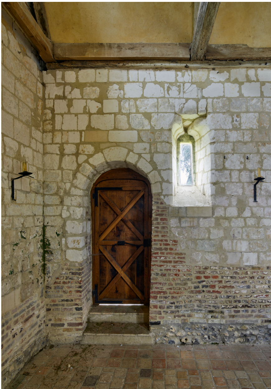
Intérieur, porte et baie sur l'élévation nord de la chapelle.
