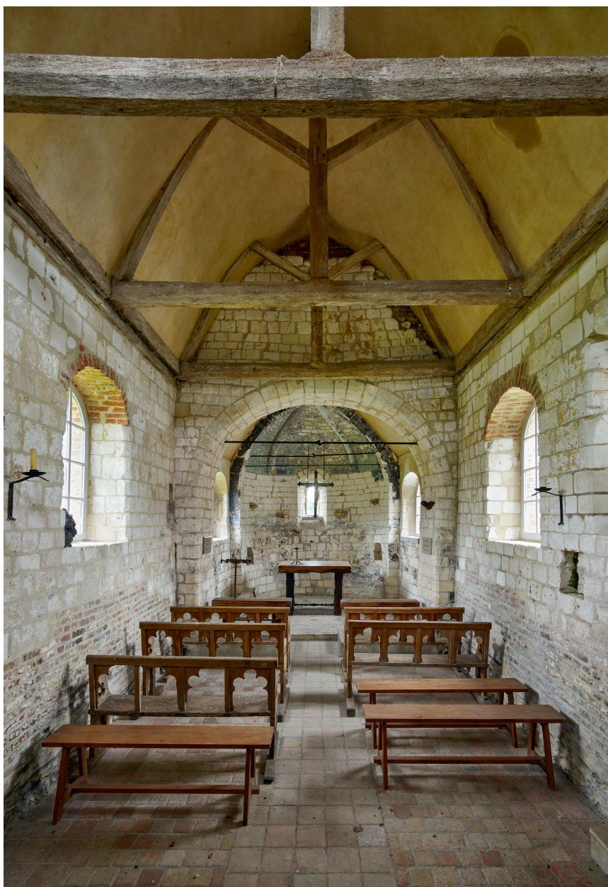
Intérieur, vue depuis l'entrée.
