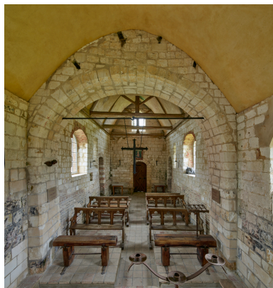
Intérieur, vue depuis l'abside. Phot. Thierry Lefébure IVR32_20248000972NUCA
