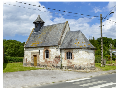
Vue d'ensemble de la chapelle, depuis le sud. Phot. Thierry Lefébure IVR32_20248000964NUCA
