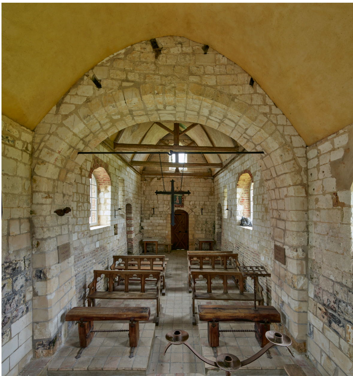
Intérieur, vue depuis l'abside.
