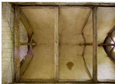
Intérieur, voûte de la chapelle. Phot. Thierry Lefébure IVR32_20248000973NUCA
