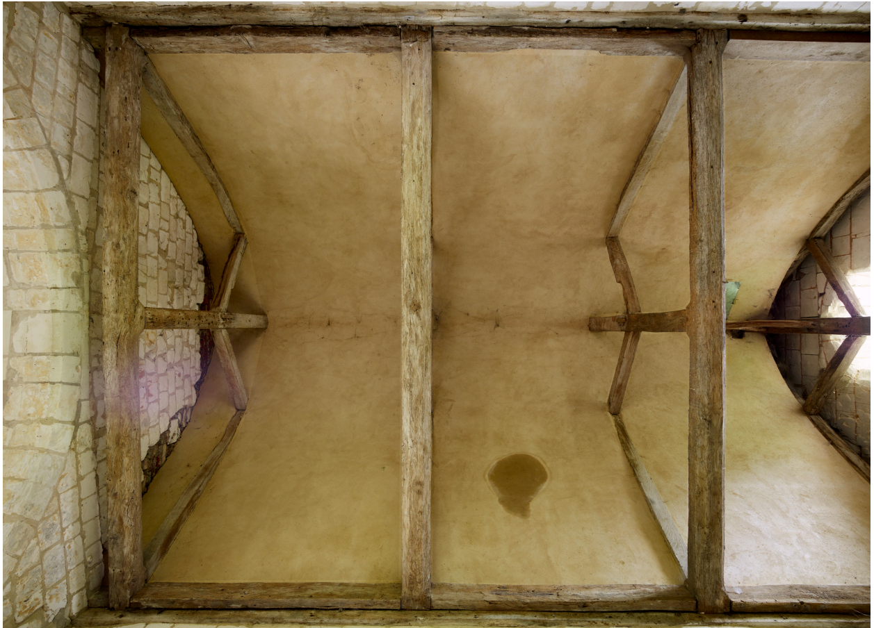
Intérieur, voûte de la chapelle.
