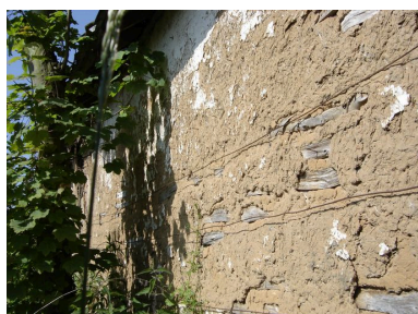
Vue détaillée de la composition du torchis. Phot. Inès Guérin IVR22_20058005861NUCA
