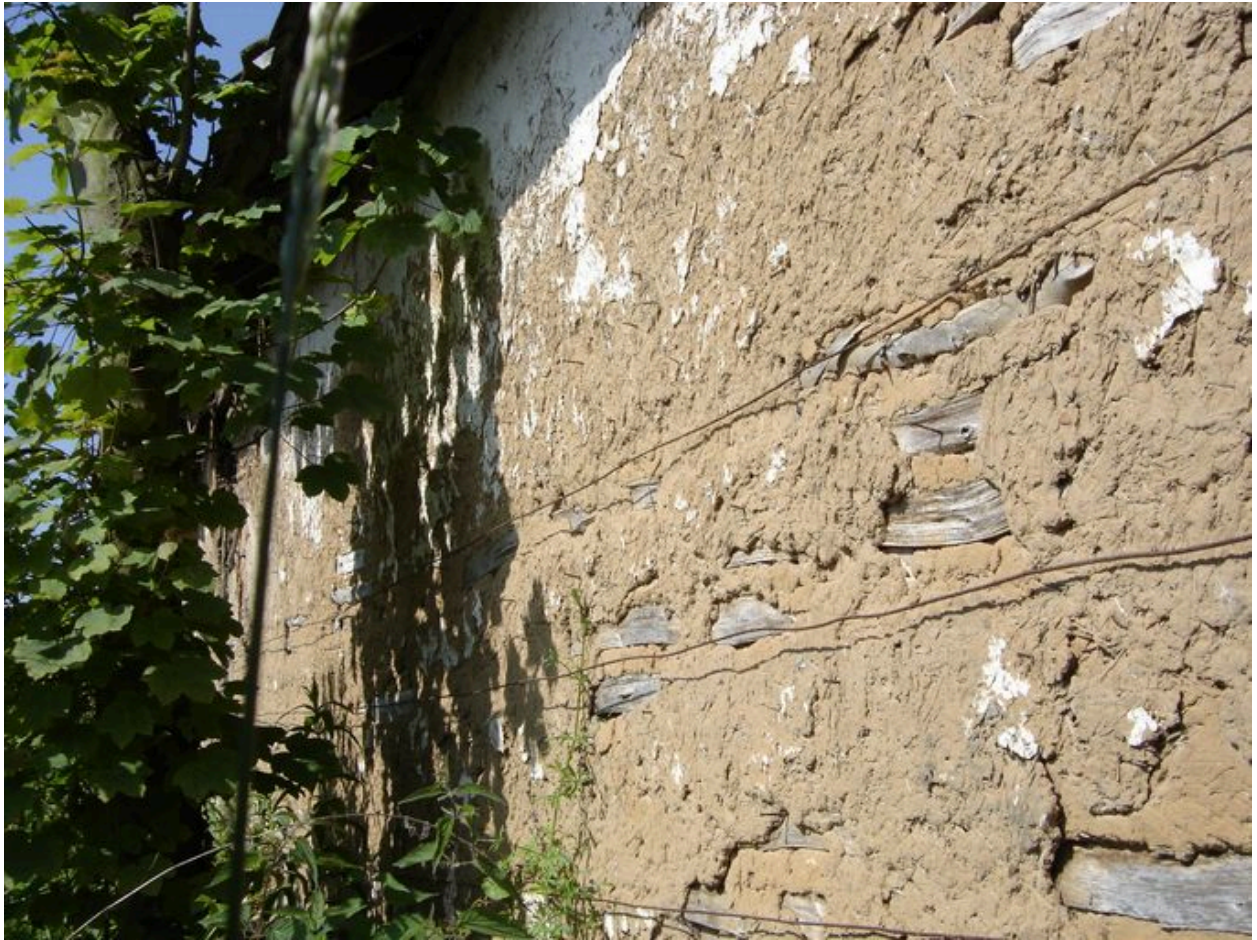
Vue détaillée de la composition du torchis.
