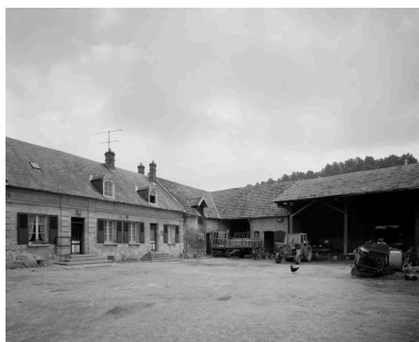
Bâtiments sur cour. Phot. Jean-Michel Perrin IVR22_19856000812V
