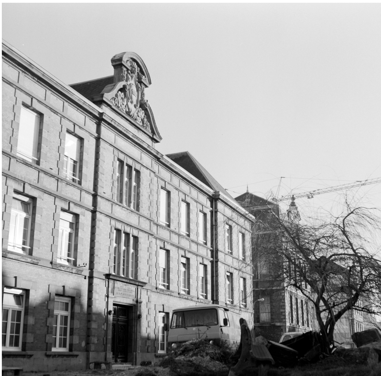
Bâtiments 1, 2, 3 : vue d'ensemble rue Louis Duflos.
