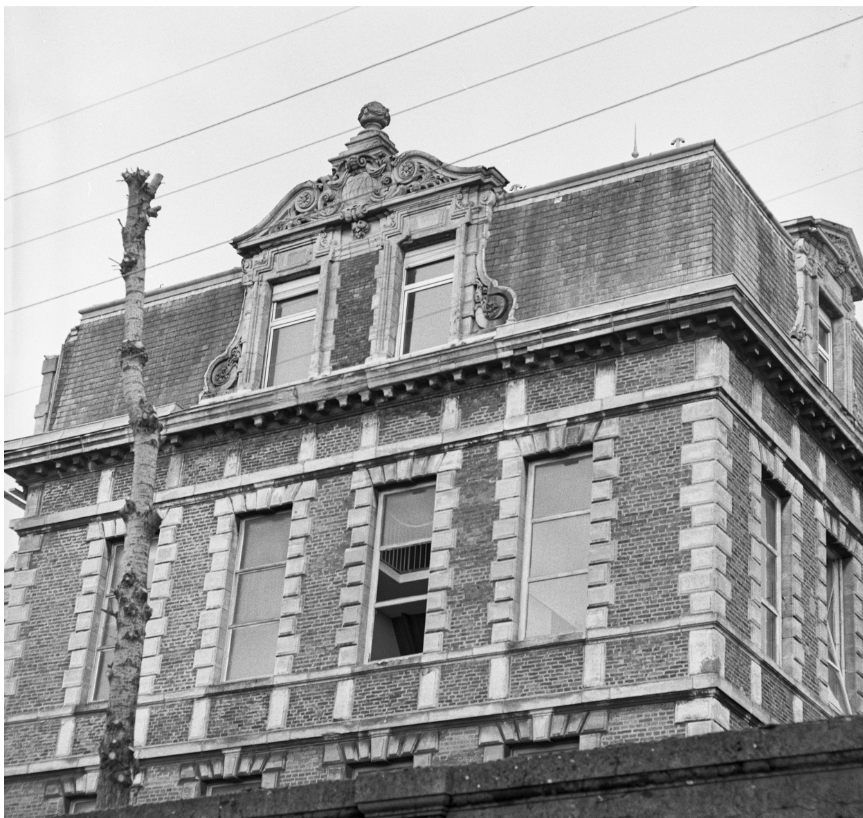
Bâtiment 1, façade rue Louis Duflos.
