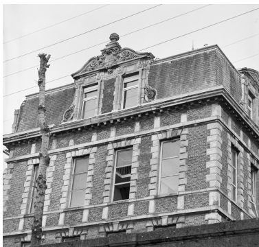
Bâtiment 1, façade rue Louis Duflos. Phot. Michèle Rougier IVR31_19966201704X
