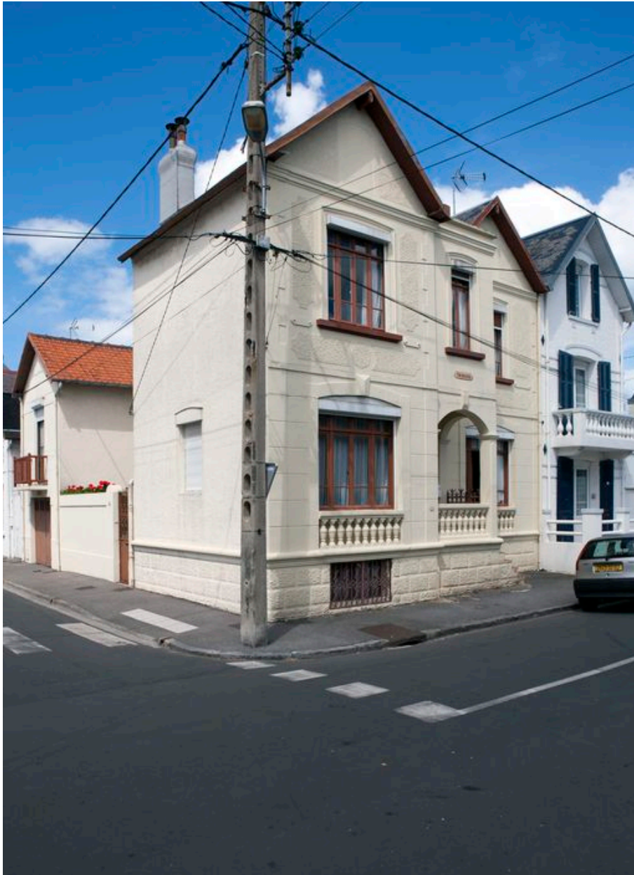
Vue générale des maisons Tribord et Bâbord.
