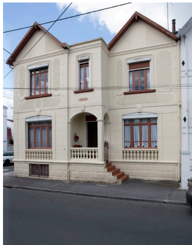
Vue générale. Phot. Pierre Thibaut IVR31_20146202180NUCA
