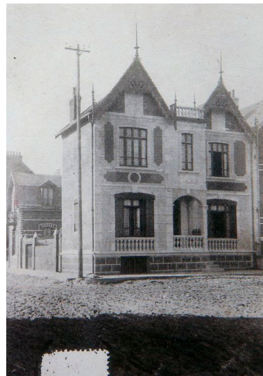
Vue générale de la maison, photographie ancienne (Archives Privées). Phot. Thibaut Pierre (reproduction) IVR31_20146202181NUCB
