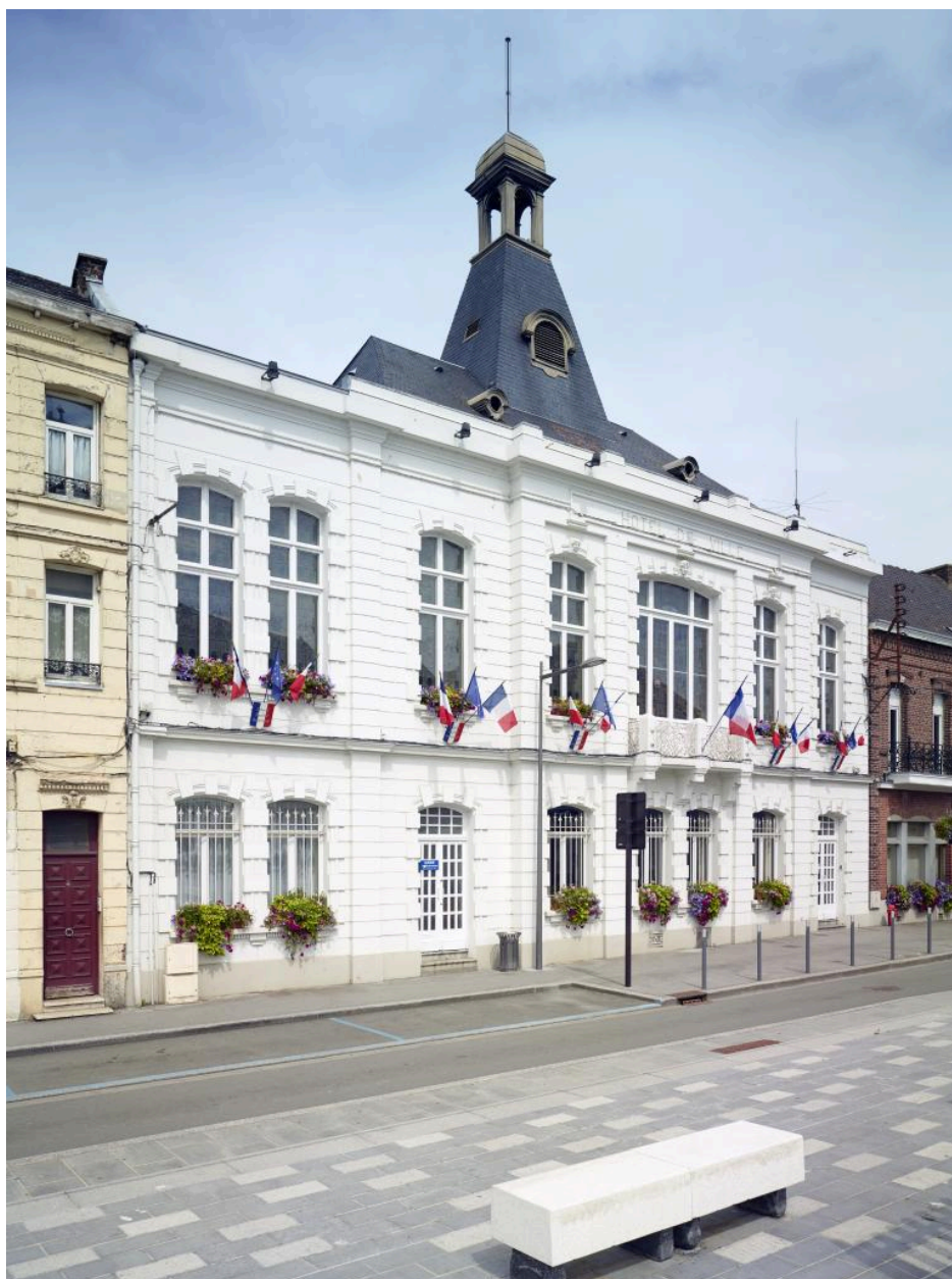
Elévation antérieure de la mairie, vers l'est.
