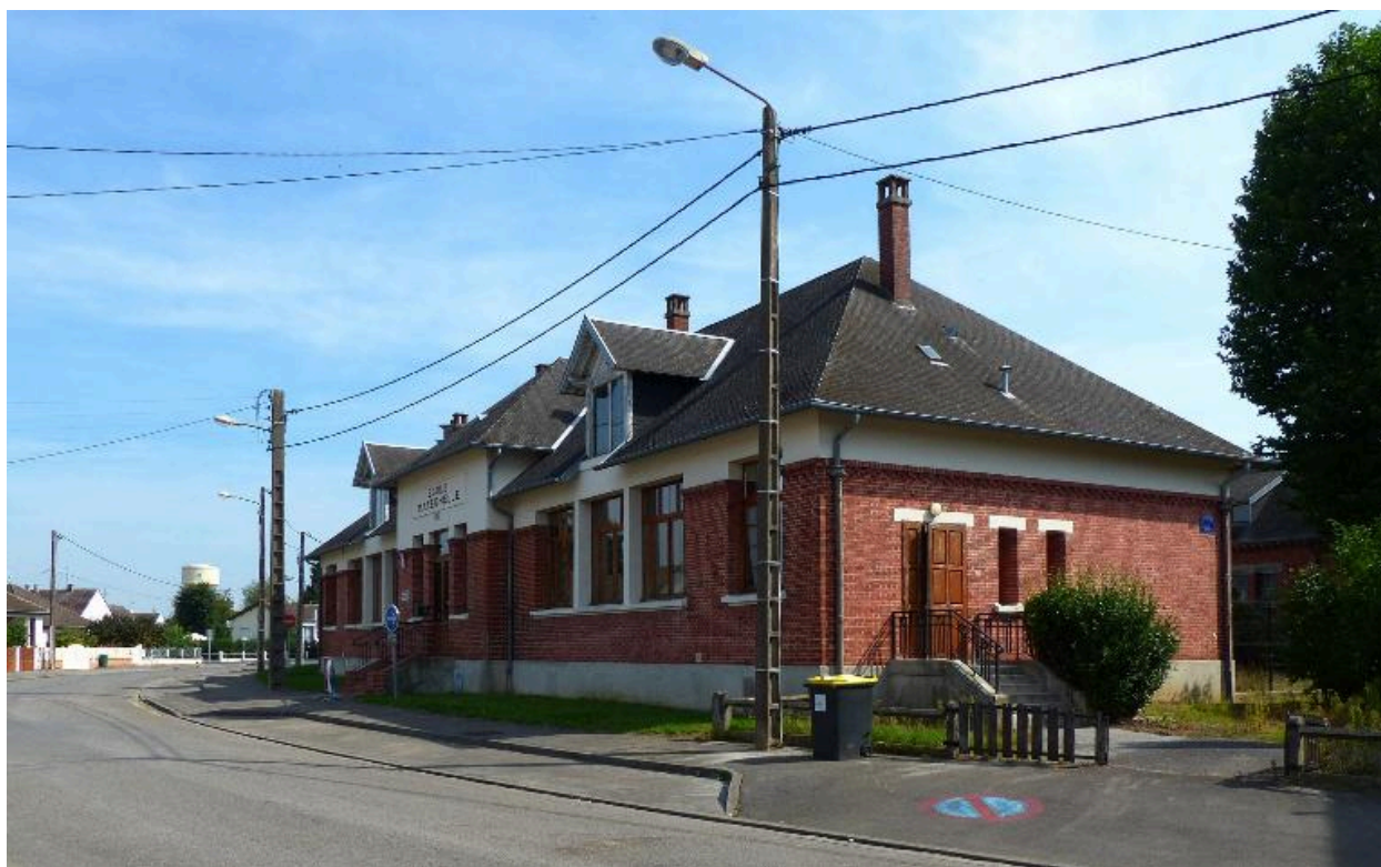
Vue depuis le boulevard des Déportés.
