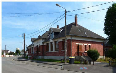
Vue depuis le boulevard des Déportés. Phot. Isabelle Barbedor IVR32_20170205508NUCA
