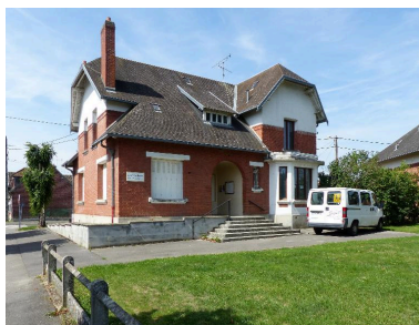
Le logement de la directrice. Phot. Isabelle Barbedor IVR32_20170205510NUCA
