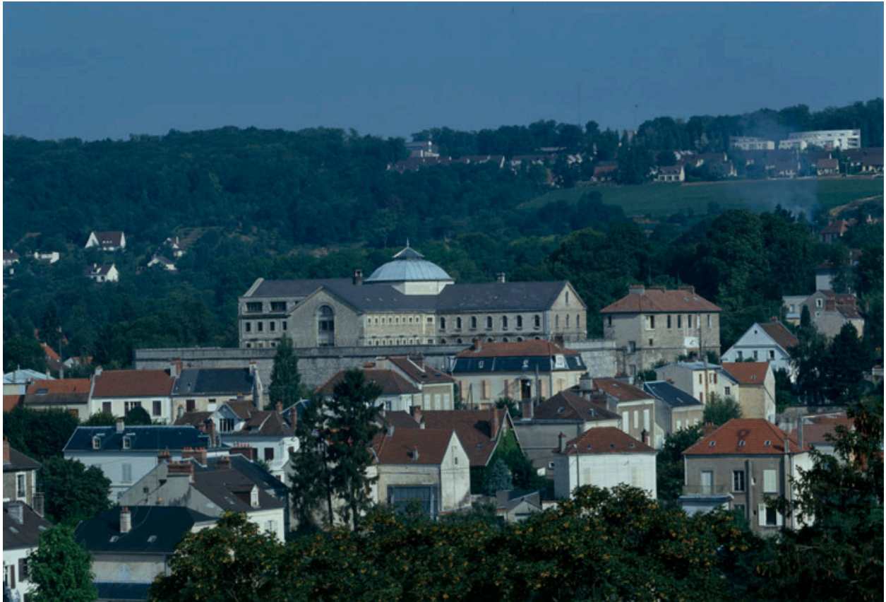
La prison vue de la plate-forme du château.
