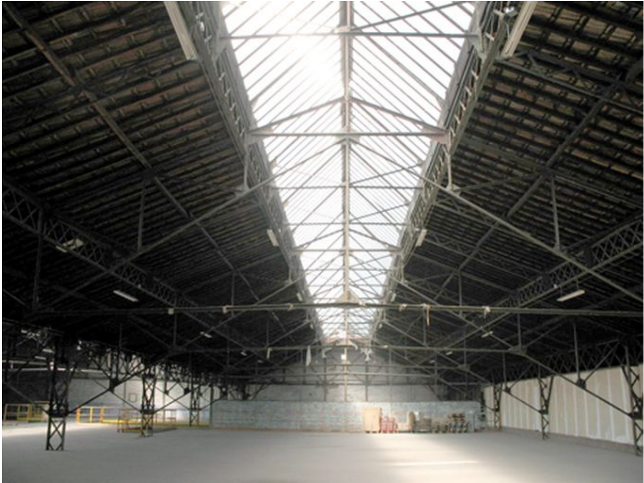
Charpente métallique des ateliers de montage.
