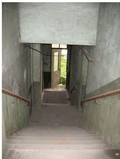
Escalier desservant les sanitaires et les vestiaires des ouvriers. Phot. Clarisse Lorieux IVR22_20076005611NUCA
