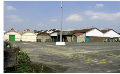
Vue générale des ateliers de fabrication. Phot. Clarisse Lorieux IVR22_20076005394NUCA
