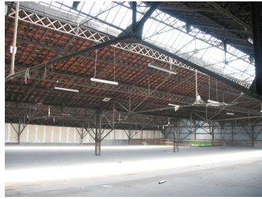
Vue générale des ateliers de montage. Phot. Clarisse Lorieux IVR22_20076005601NUCA
