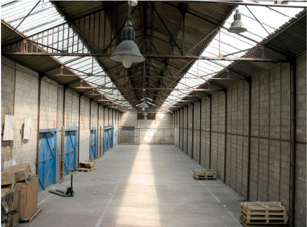
Bâtiment de stockage.
