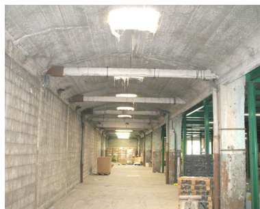
Bas-côté de la fonderie. Phot. Clarisse Lorieux IVR22_20076005606NUCA
