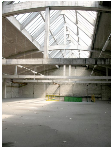
Lanterneau vitré éclairant l'extension de la fonderie. Phot. Clarisse Lorieux IVR22_20076005608NUCA
