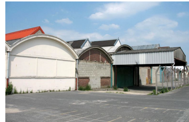
Détail des ateliers de montage. Phot. Clarisse Lorieux IVR22_20076005398NUCA
