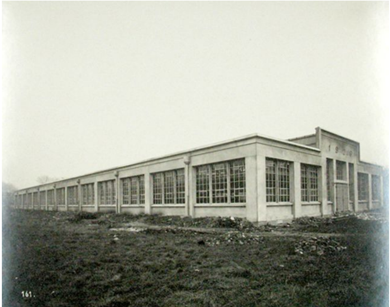
Vue générale de l'atelier de peinture construit par les architectes Perret, 1926 (IFA ; 535 AP 651/12).
