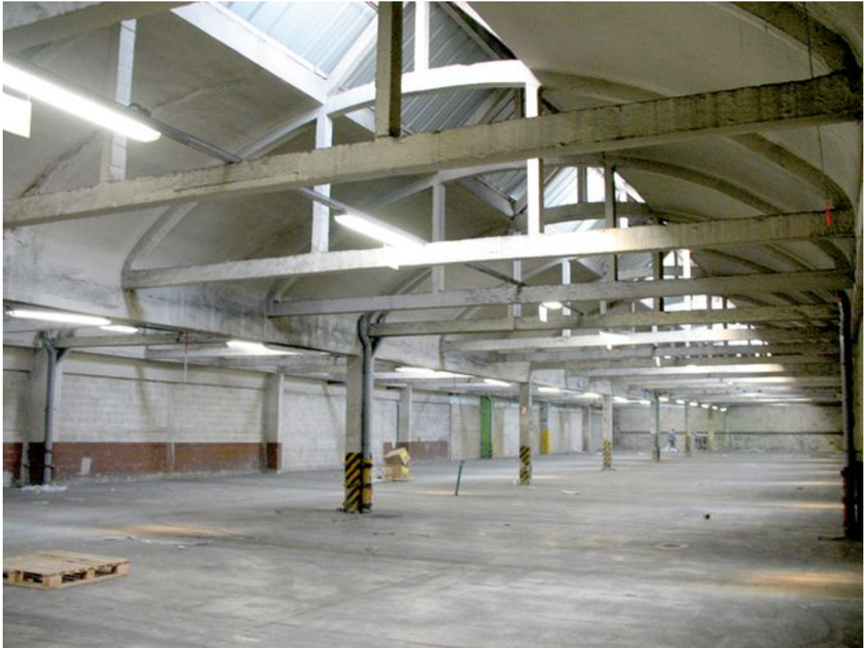
Atelier de mécanique construit par Perret.
