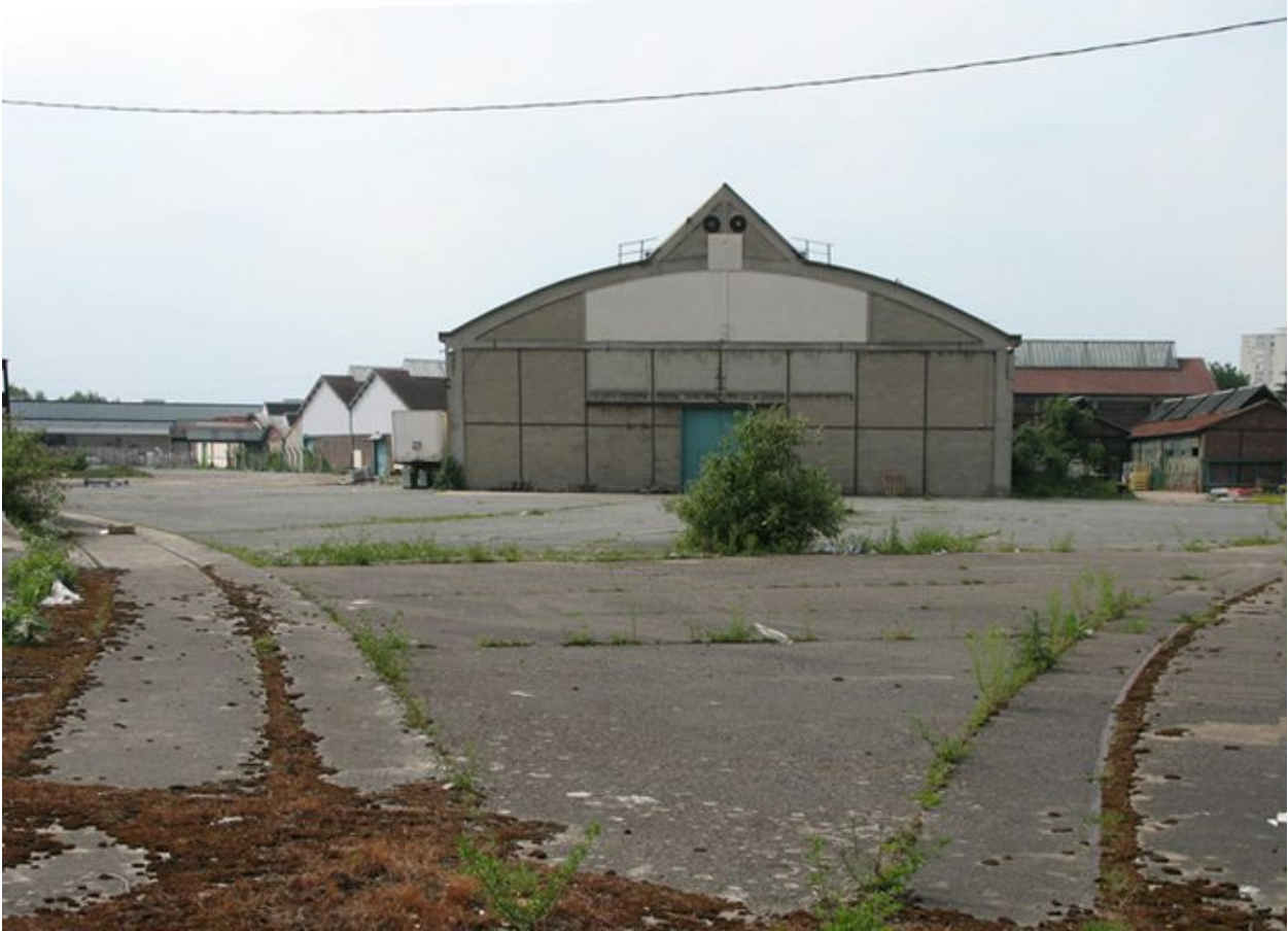
Rails desservant les différents bâtiments.
