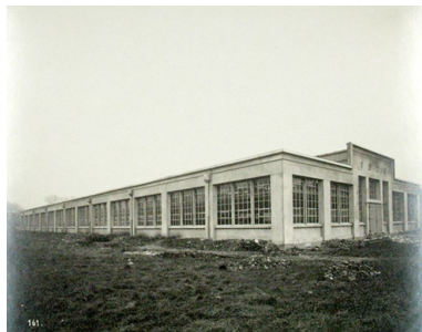
Vue générale de l'atelier de peinture construit par les architectes Perret, 1926 (IFA ; 535 AP 651/12). Phot. Clarisse Lorieux IVR22_20076005541NUCAB
