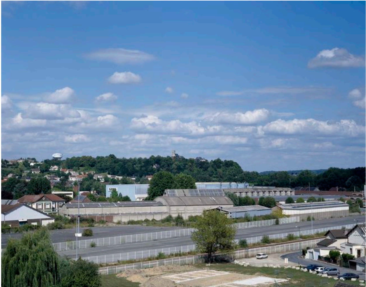
Vue générale de l'ancien site de la Cima-Wallut depuis Thiverny.
