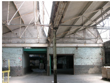
Détail des travées couvertes en sheds. Phot. Clarisse Lorieux IVR22_20076005603NUCA
