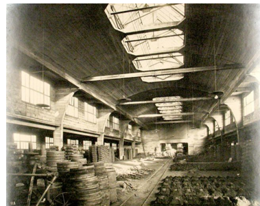
Intérieur de la fonderie construite par les architectes Perret au milieu des années 1920 (IFA ; 535 AP 651/12). Phot. Clarisse Lorieux IVR22_20076005542NUCAB
