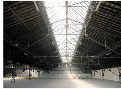
Charpente métallique des ateliers de montage. Phot. Clarisse Lorieux IVR22_20076005600NUCA
