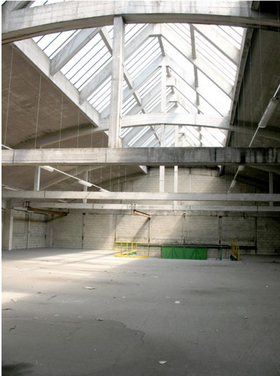
Lanterneau vitré éclairant l'extension de la fonderie.
