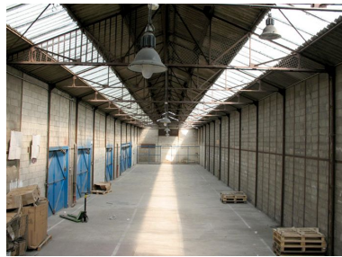
Bâtiment de stockage. Phot. Clarisse Lorieux IVR22_20076005609NUCA
