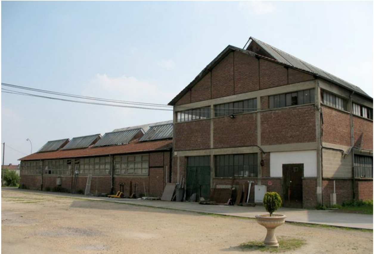
Bâtiments annexes à la fonderie.
