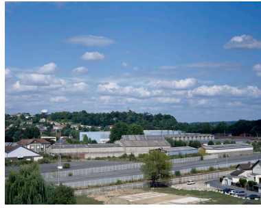
Vue générale de l'ancien site de la Cima-Wallut depuis Thiverny. Phot. Thierry Lefébure IVR22_20106000742VA
