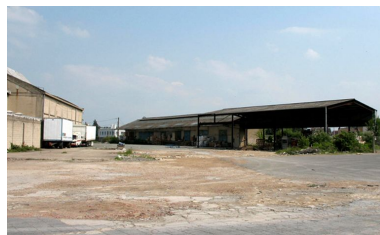
Quais de déchargement. Phot. Clarisse Lorieux IVR22_20076005400NUCA
