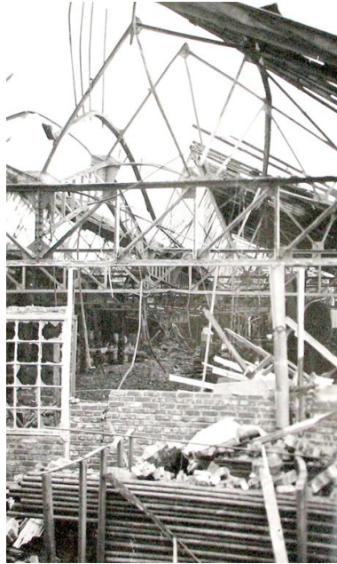
Bombardement du 23 mars 1944 : bombe n°11 tombée sur les forges et le bâtiment des presse, pignon ouest (AD Oise ; 753W28740). Phot. Clarisse Lorieux IVR22_20086005089NUCAB
