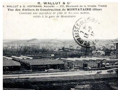
Vue des ateliers de construction, vers 1910 (AC Creil). Phot. Clarisse Lorieux IVR22_20076005417NUCAB
