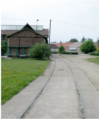
Rails desservant les bâtiments annexes de la fonderie. Phot. Clarisse Lorieux IVR22_20076005597NUCA
