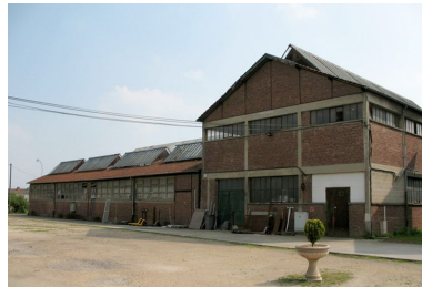
Bâtiments annexes à la fonderie. Phot. Clarisse Lorieux IVR22_20076005594NUCA
