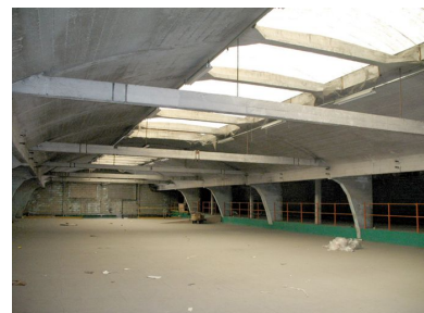
Voûte en béton et éclairage zénithal du bâtiment de la fonderie. Phot. Clarisse Lorieux IVR22_20076005607NUCA
