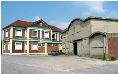
Les bureaux et la fonderie. Phot. Clarisse Lorieux IVR22_20076005395NUCA
