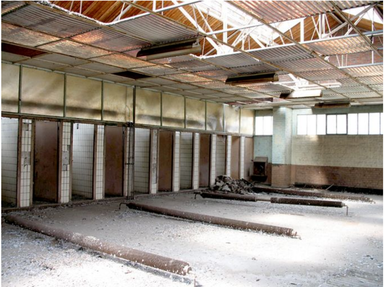
Ancien vestiaire avec au fond les douches.
