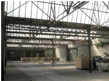
Atelier de montage couvert en sheds. Phot. Clarisse Lorieux IVR22_20076005602NUCA
