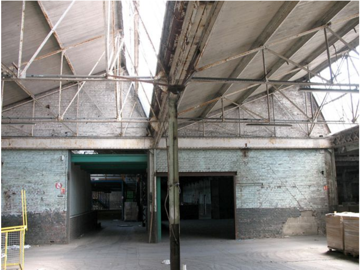
Détail des travées couvertes en sheds.
