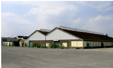
Ateliers de montage des pièces. Phot. Clarisse Lorieux IVR22_20076005397NUCA
