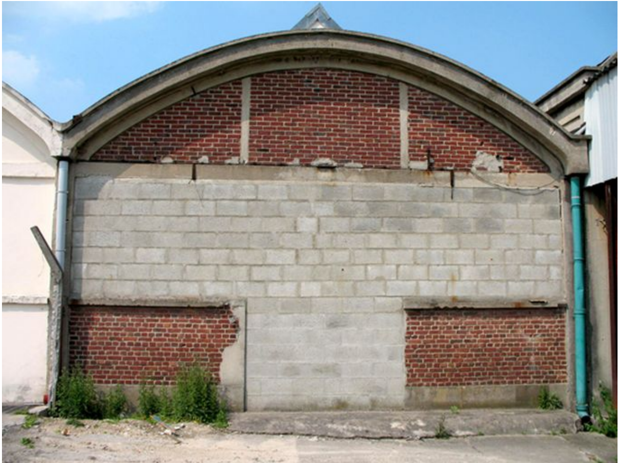
Détail d'une travées des ateliers de fabrication.
