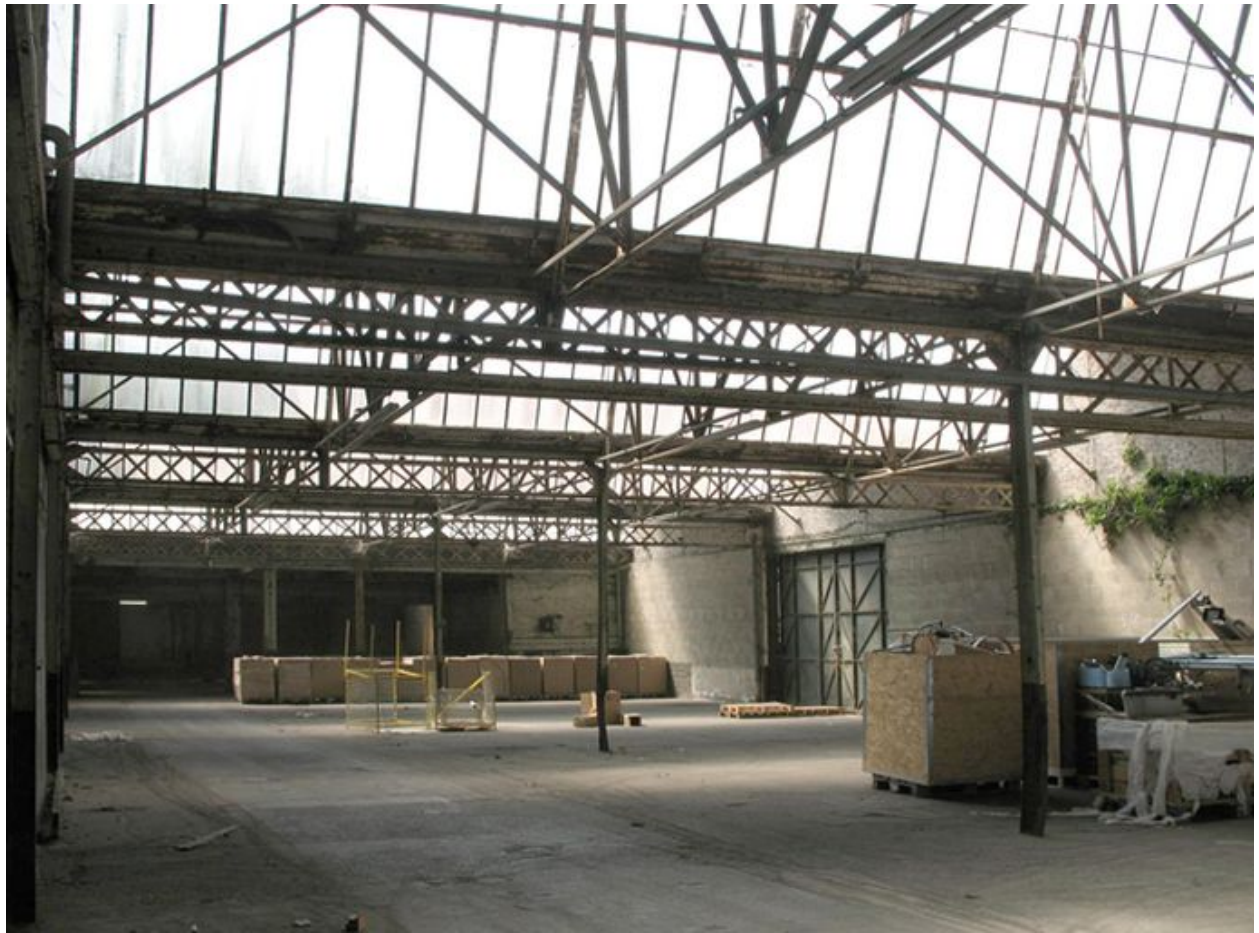
Atelier de montage couvert en sheds.
