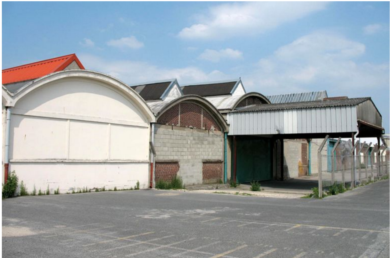
Détail des ateliers de montage.
