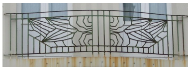
1er étage, détail : balcon.
