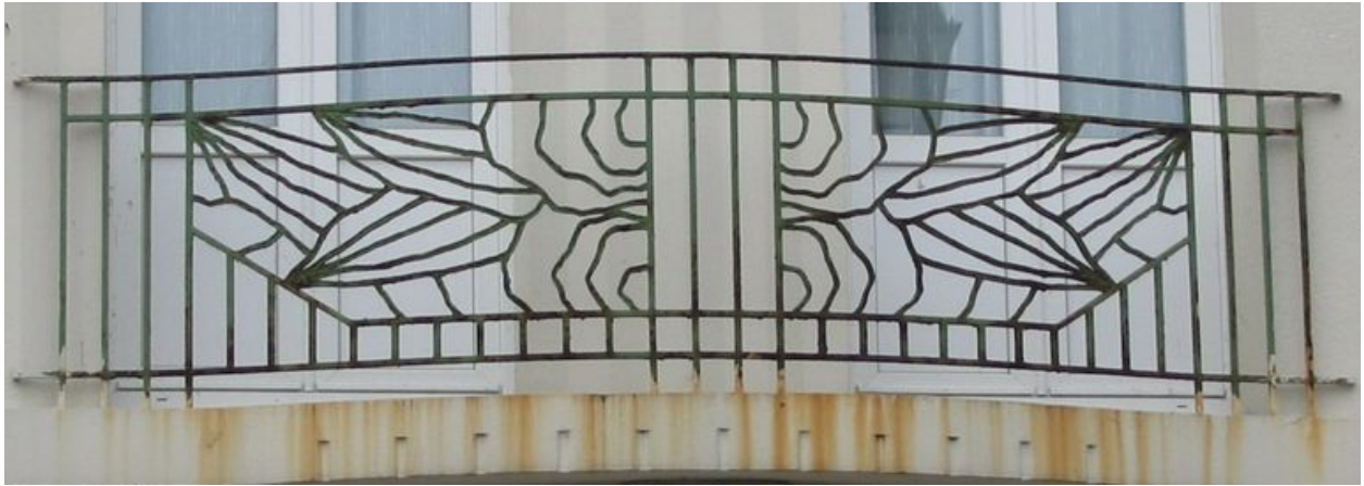
1er étage, détail : balcon.
