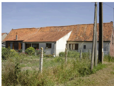
Vue sur la face ouest de l'ensemble. Phot. Catherine Fourmond IVR22_20058001599NUCA
