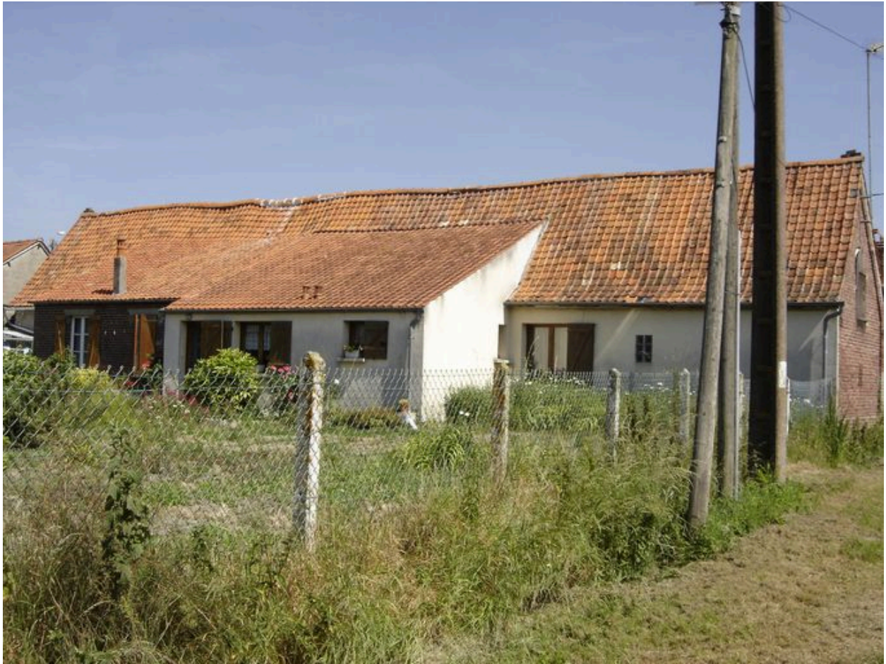
Vue sur la face ouest de l'ensemble.
