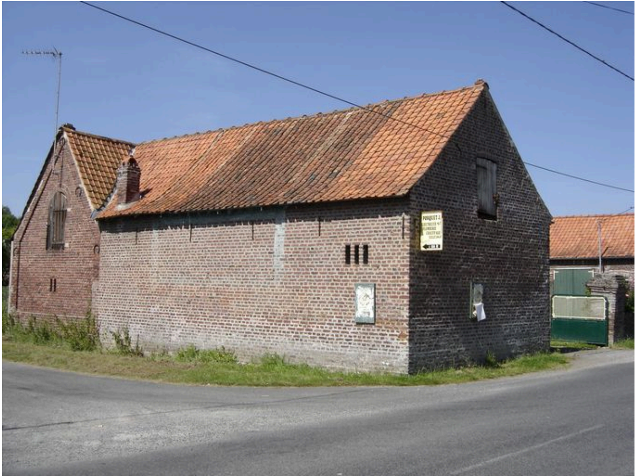
Vue sur la face sud de la grange.
