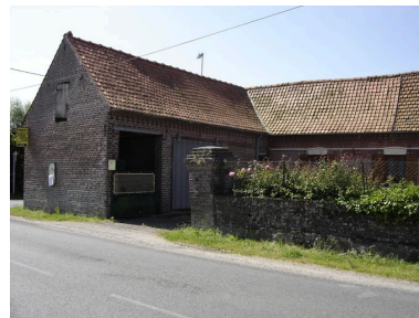
Vue sur la grange au sud. Phot. Catherine Fourmond IVR22_20058001597NUCA
