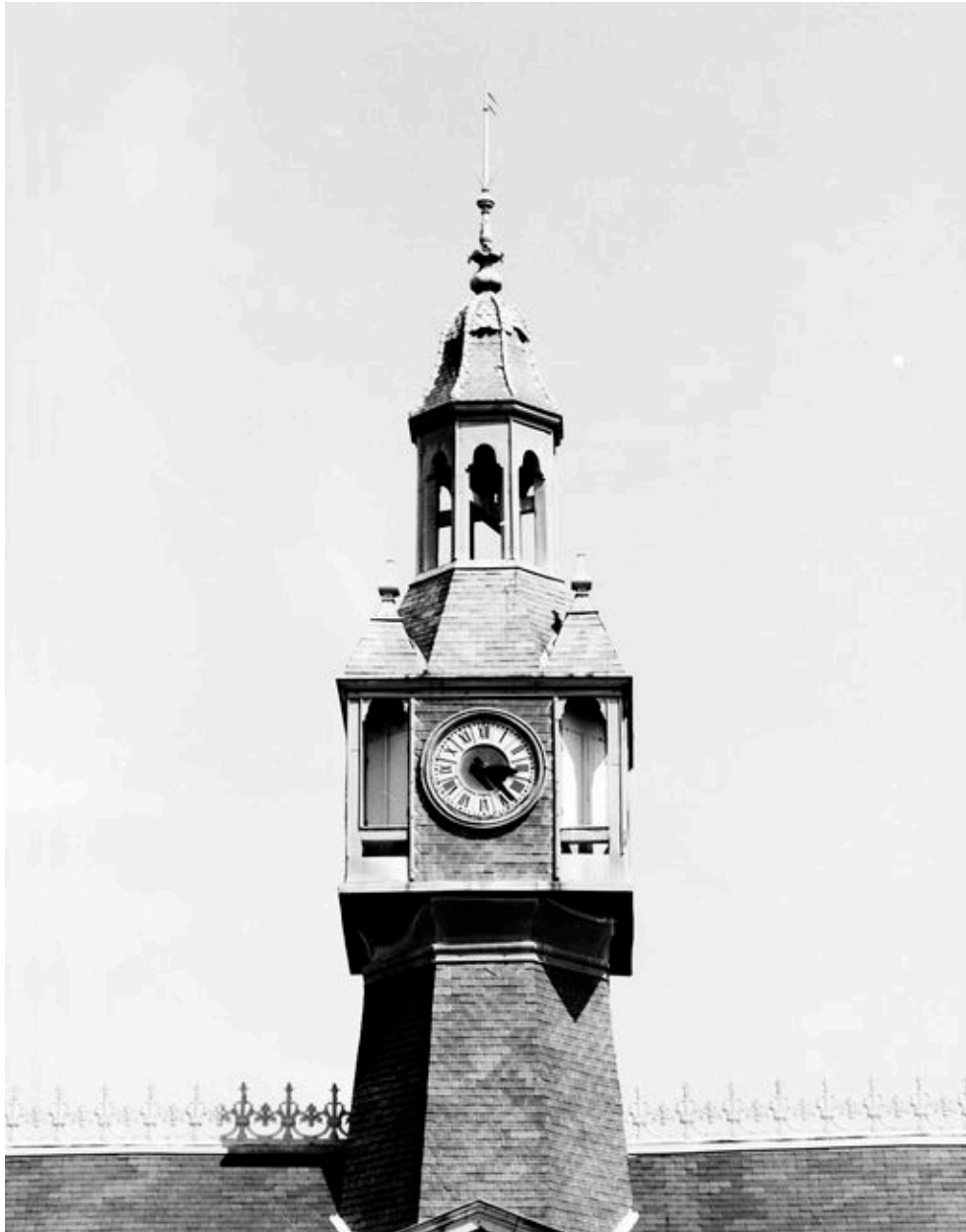
Détail : le couronnement de la toiture et le clocheton, en 1981.
