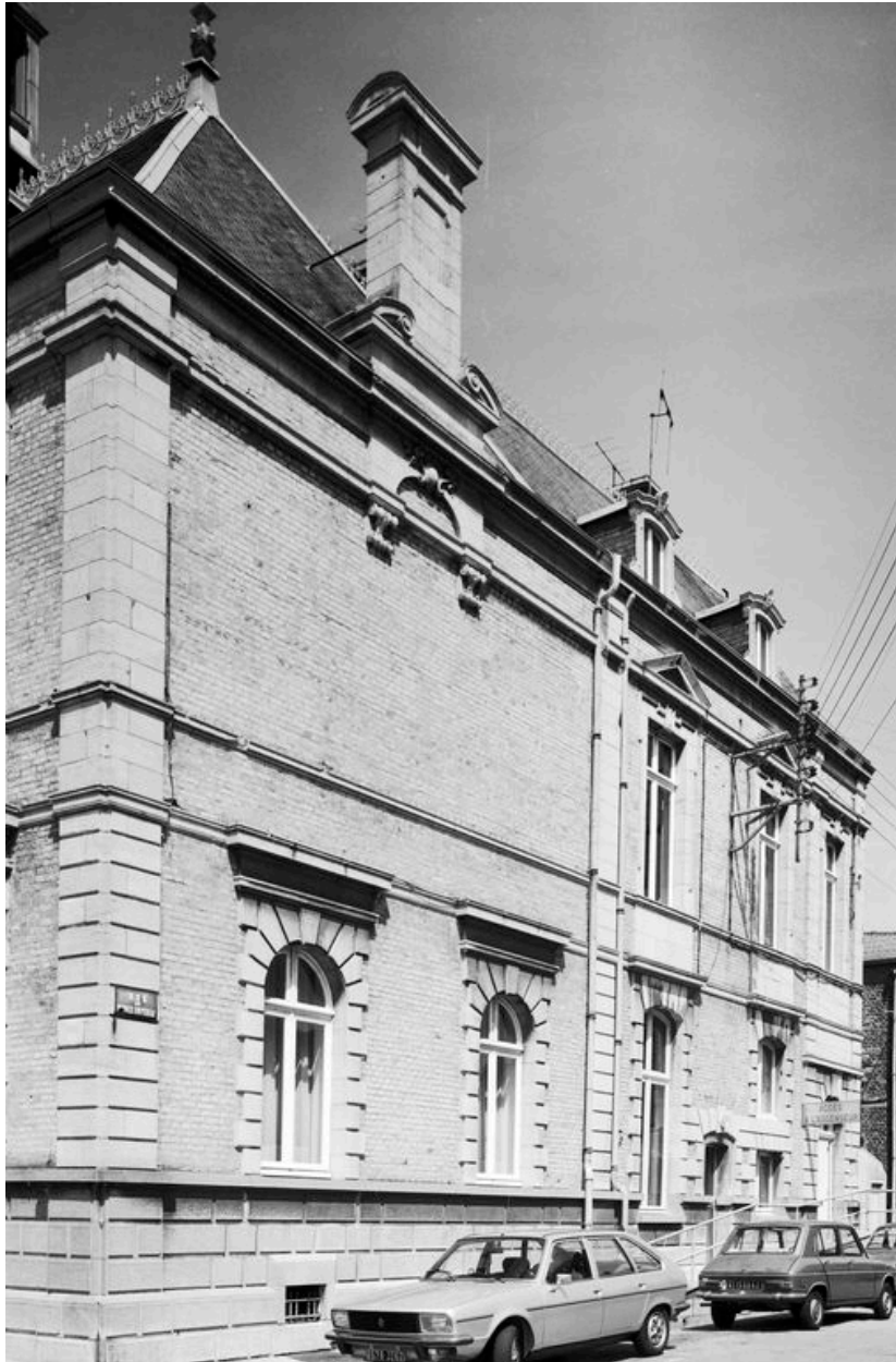
Elévation latérale, rue du Prince-Impérial, en 1981.
