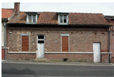
Façade sur rue du logement du n°5 rue Beldame. Phot. Bertrand Fournier IVR22_20128005090NUCA
