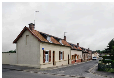
Vue d'ensemble de la cité ouvrière, depuis la rue de Flixecourt. Phot. Thierry Lefébure IVR22_20128000274NUC2A
